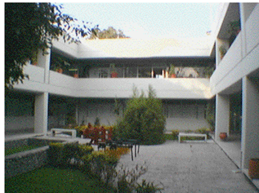
El interior del edificio cuenta con una pequeña plaza. Las ventanas están protegidas del asoleamiento por pasillos.
