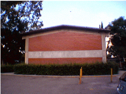
El edificio de cubículos y cuenta con una cubierta a dos aguas.
