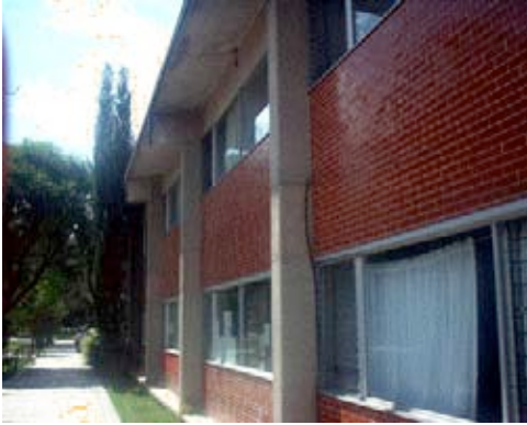
Fachada sur del edificio de cubículos y dirección.
