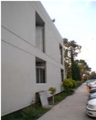
Fachada oriente. El edificio está cubierto por losas planas.
