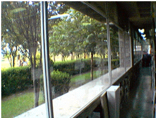
La fachada poniente es protegida del asoleamiento por una barrera natural.
