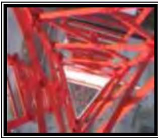
La conforman las piernas, cerramientos horizontales, cerramientos diagonales, cerramientos secundarios, placas de unión de cerramientos diagonales y secundarios, diafragmas y tornillería.
