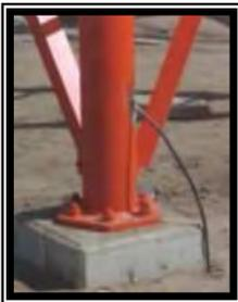
Soldar con cadwell cable de 2/0 de cobre forrado a cada una de las piernas de la torre y con soldadura cadwell aterrizarlal sistema de tierras.
