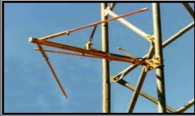
La antena de la figura 17 es una antena marca JAMPRO JLLP de baja potencia diseñada para estaciones con buena fidelidad y larga vida, FM de baja potencia.
