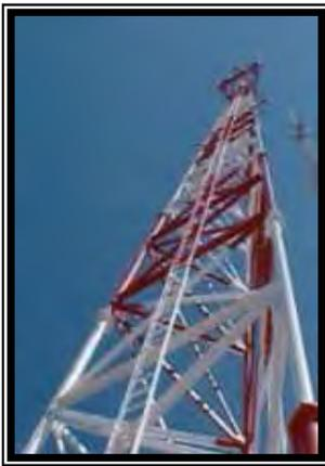
Una torre auto soportada o auto sustentada (Figura 8), se le denomina a aquella estructura metálica que se puede soportar por sí misma, es decir, no requiere de elementos externos para sostenerse como en el caso de la torres soportadas o arriostradas, las cuales necesitan de las retenidas para mantenerse en pie.
