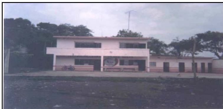
Foto No. 5: Telebachillerato de la Comunidad Tierra Nueva
