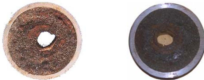
Fig. 1.28. Cortes de tuberías obstruidas por parafinas
