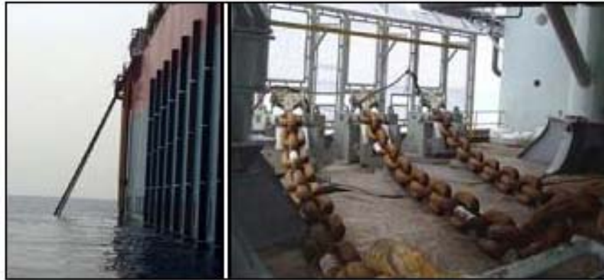
Fig.3.49. Cadenas de anclaje.
