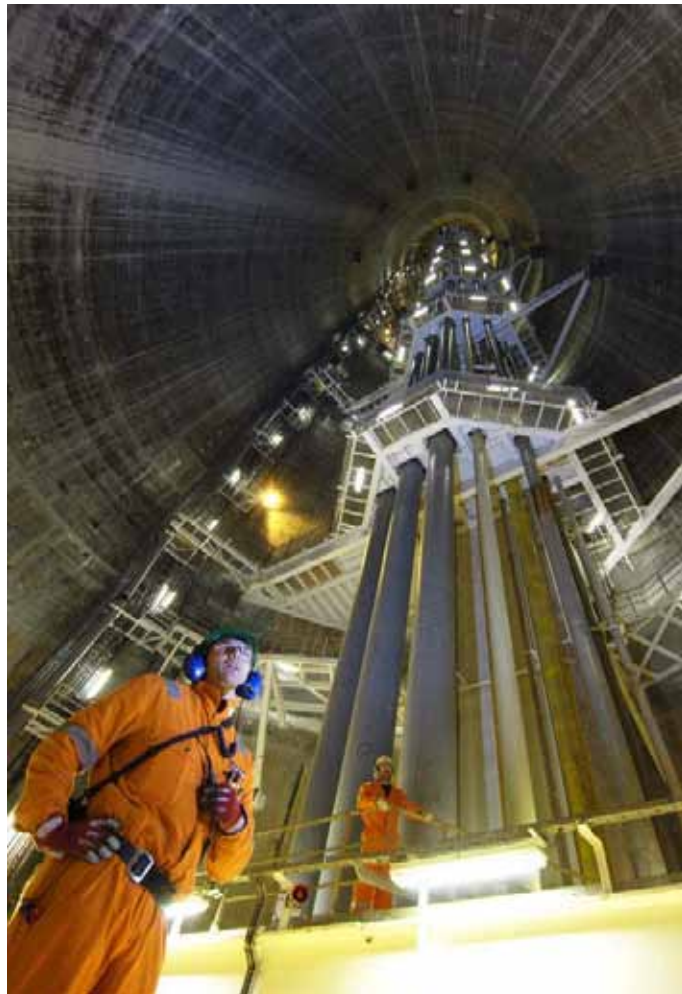
Fig.3.6. Risers instalados en una plataforma de concreto.
