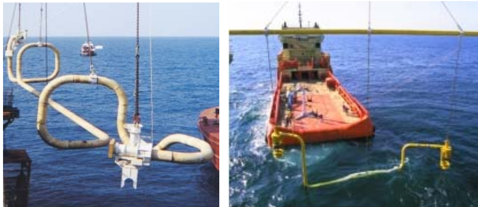
Fig. 2.25. Instalación de jumpers .
