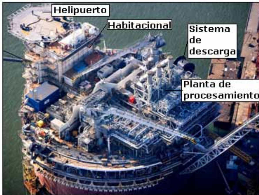
Fig.3.28. Cubierta de la SSP.
