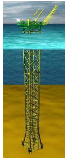
Fig.3.8. Estructura tubular de acero ( jaket ).
