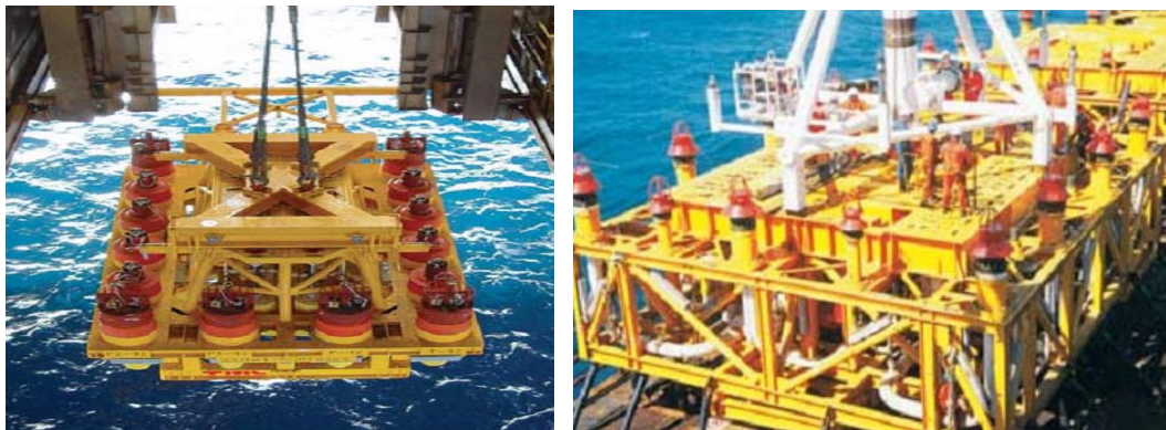
Fig. 2.13. Transporte e instalación de manifolds.
