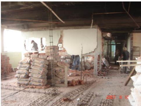
TRABAJOS DE DEMOLICIONES DE MUROS DIVISORIOS
