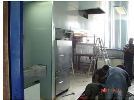
DESMANTELAMIENTO DE AUTOCLAVES DE ESTERILIZACION DEL CEYE.
