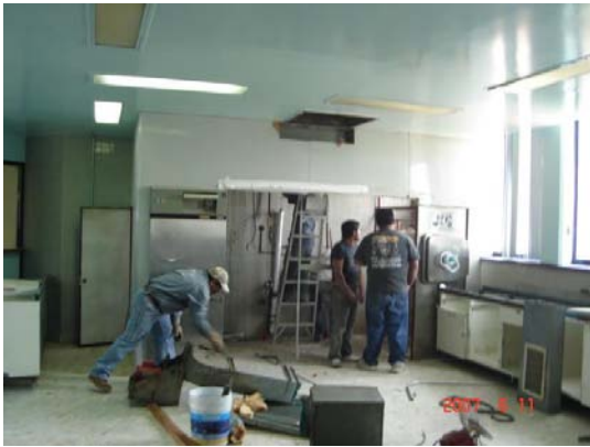
DESMANTELAMIENTO DE AUTOCLAVES DE ESTERILIZACION DEL CEYE.
