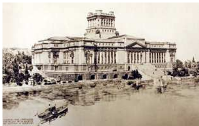
14) Edificio de la Sociedad de Naciones. Proyecto de Adamo Boari y Giuseppe Boni. Fuente: Edición conmemorativa.
