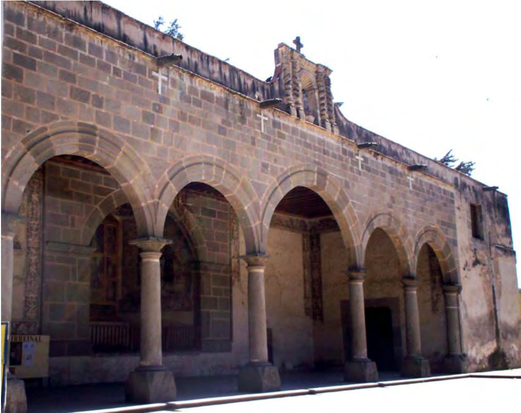
Figura 8. Vista de la capilla abierta
