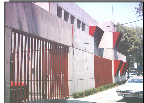
Fachada norte de la estación.
