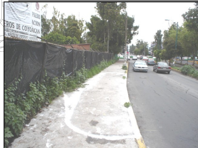
4. Banqueta y predio de la Setravi que se recortaran 4.5 mts para ampliar la Av. Canal Nacional.
