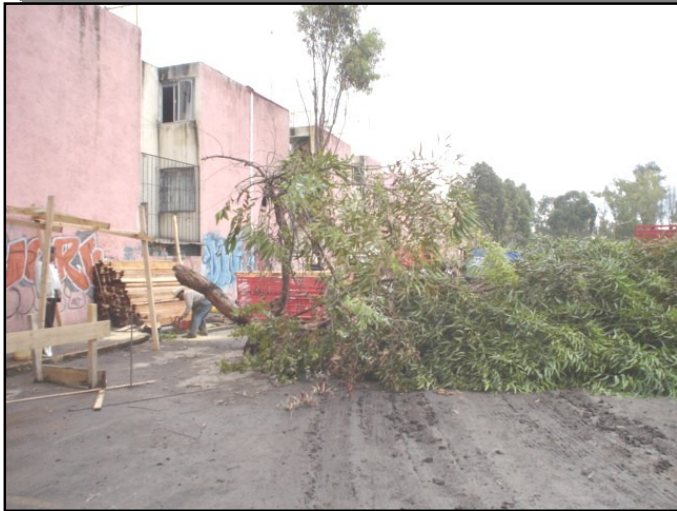
1. Vista del terreno hacia el conjunto habitacional con el que colinda
