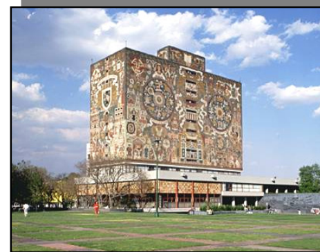
La construcción de la Universidad representa una etapa importante para la consolidación de Coyoacán.
