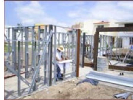
ESTRUCTURA DE ACERO GALVANIZADO
