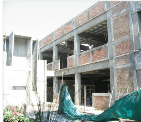
Construcción a un costado del edificio principal de TV UNAM
