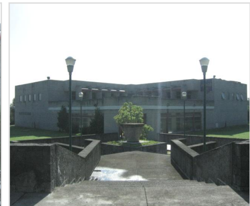
Fachada principal, en dos niveles de altura
