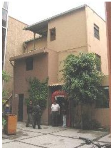
Edificio de laboratorios del CUEC
