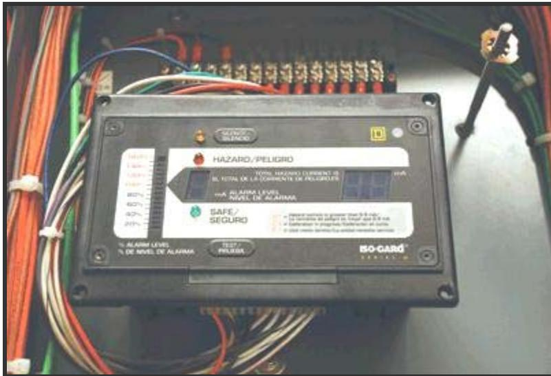
Figura 5.9: Monitor de Aislamiento de Línea
