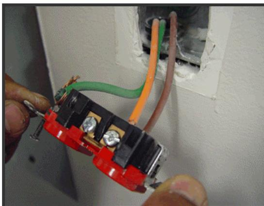
Figura 6.16: Identificación de conductores de un circuito aislado. Conductor aislado 1 (naranja) ;
