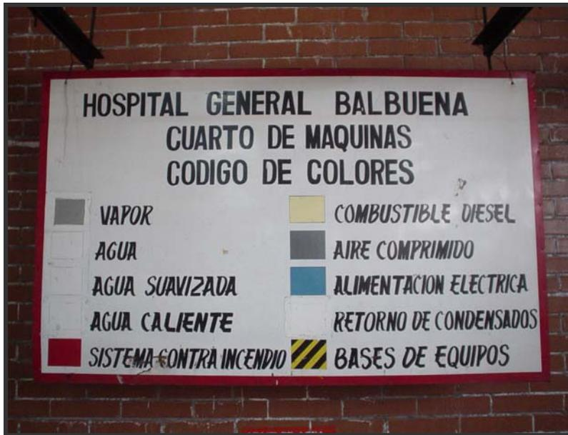
Figura 3.10: Cuarto de Máquinas
