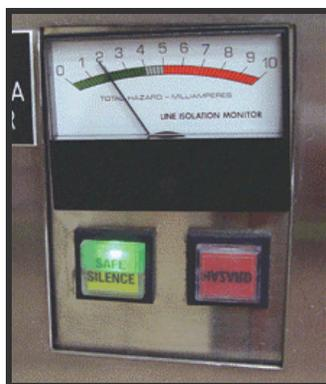
Figura 6.17: Señalización del monitor de aislamiento de línea.
