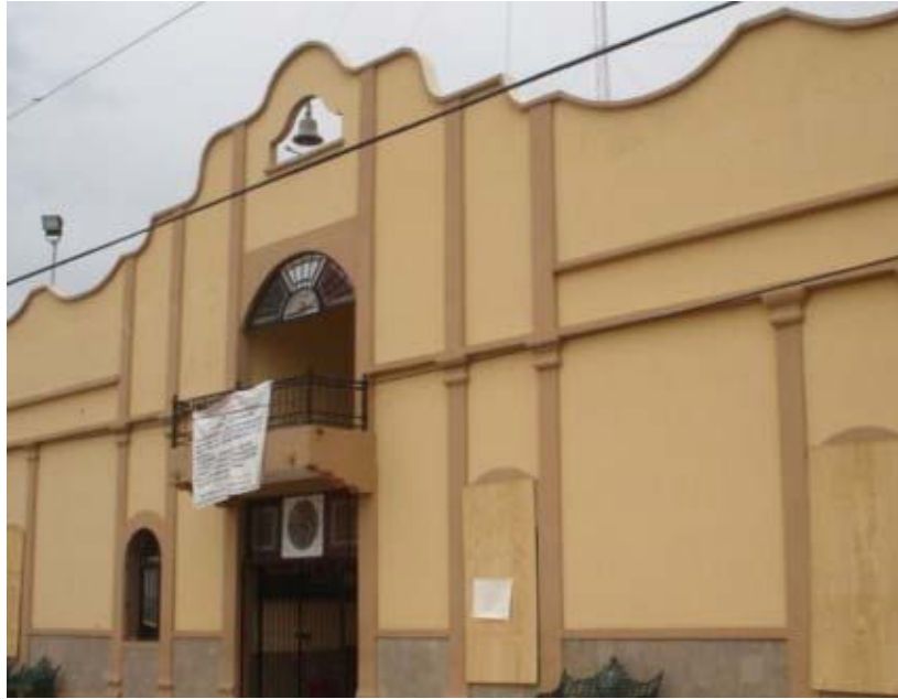
Fig. 1.16. Palacio municipal ubicado en la Villa de Tecolutla.
