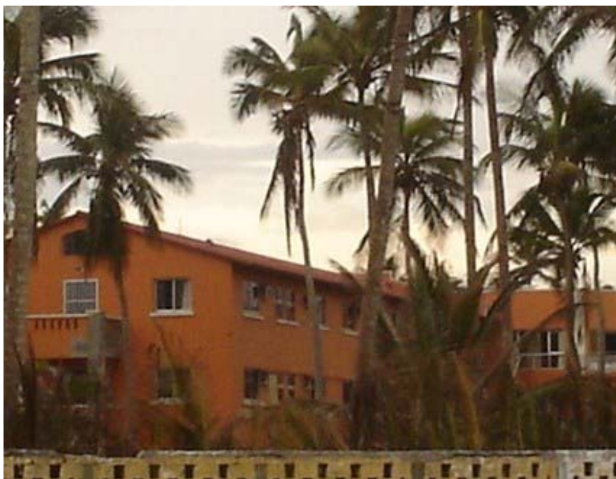
Fig. 3.2. Vista del Hotel Balneario "Tecolutla".
