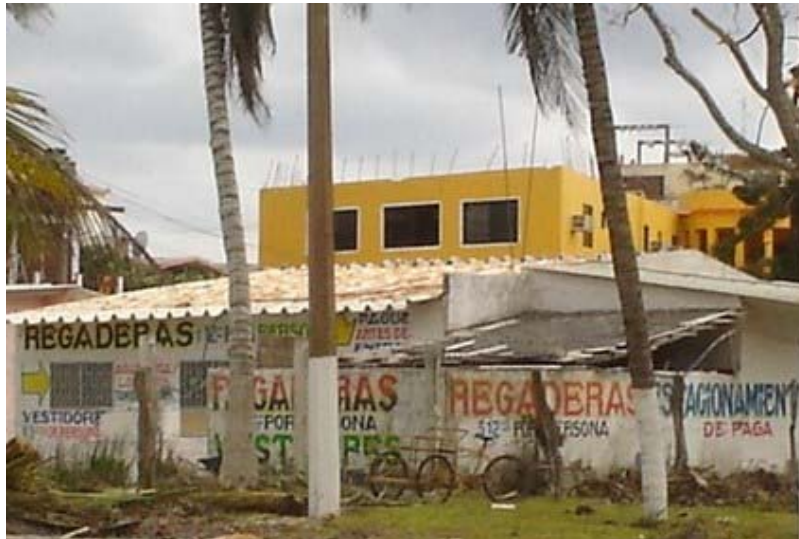
Fig. 3.13. Regaderas y sanitarios en la franja litoral.
