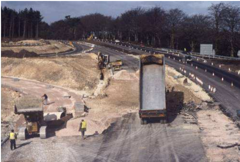
FIGURA 1.14 “CONSTRUCCION DE UNA CARRETERA”
