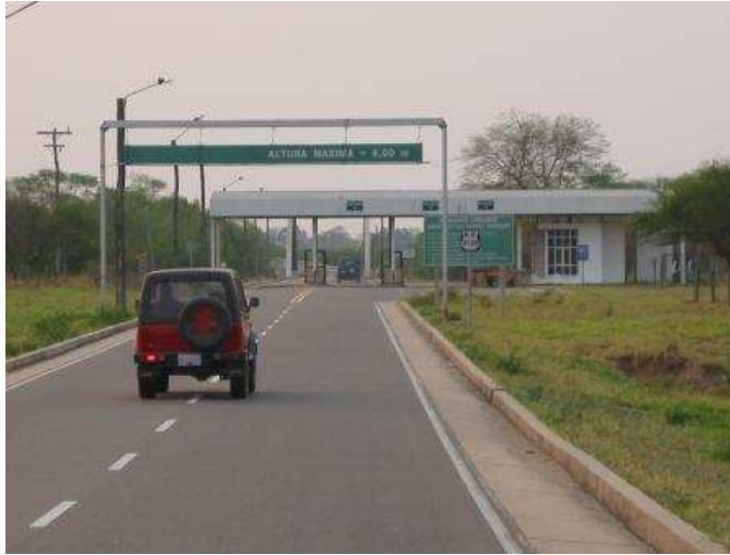
FIGURA 1.10 “CASETA DE COBRO O PEAJE”
