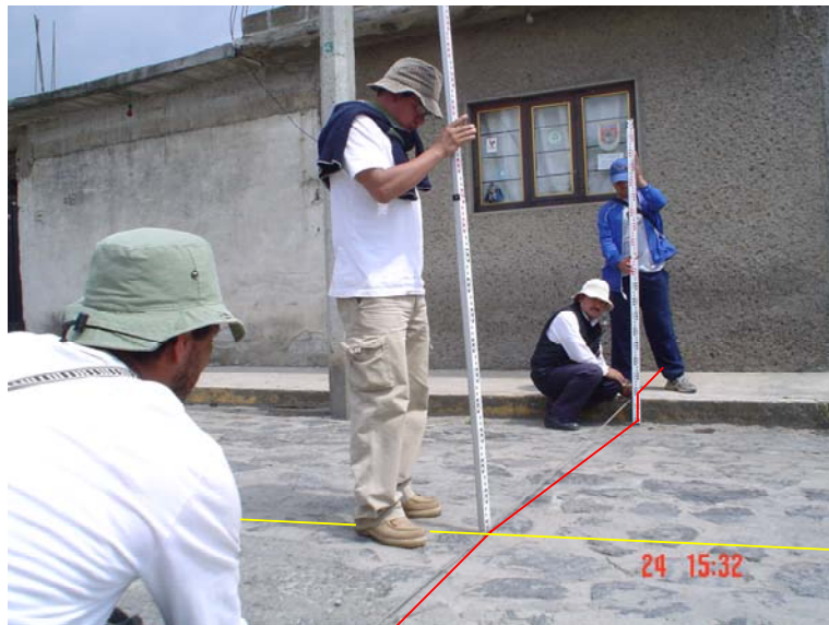
Fig. IV.5. Nivelación de sección transversal.
