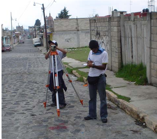
Fig. IV.11. Nivelación de eje y secciones.
