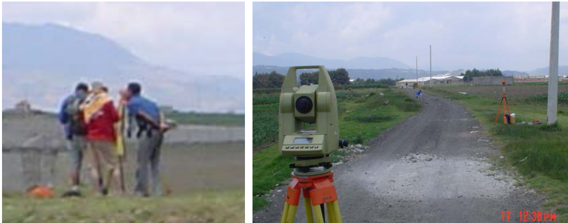
Fig. IV.6 y IV.7. Obtención y nivelación del eje de proyecto.
