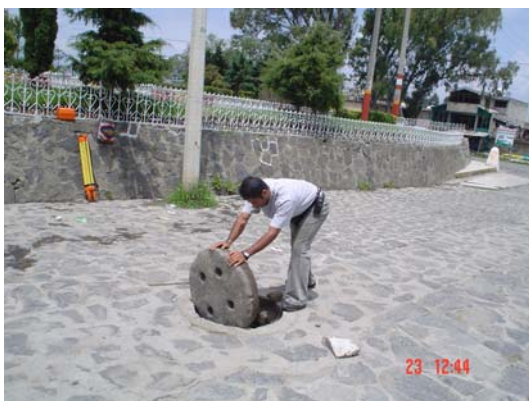
Figs. IV.3 y IV.4. Nivelación de pozos de visita.
