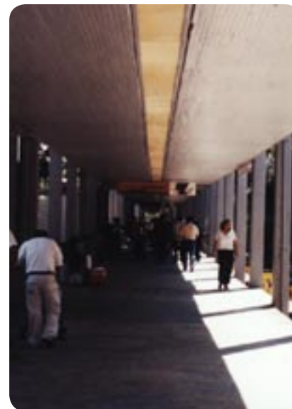
FIGURA 1.16 Corredor que comunica todas las Instalaciones.
