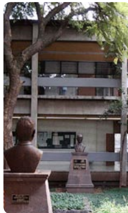
FIGURA 1.5 Edificio 3, zona de aulas.
