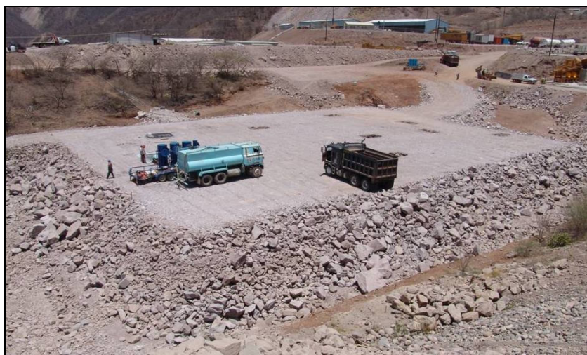
FIGURA II.45 PEDRAPLÉN DE PRUEBAS DURANTE LA ETAPA DE CONSTRUCCIÓN
