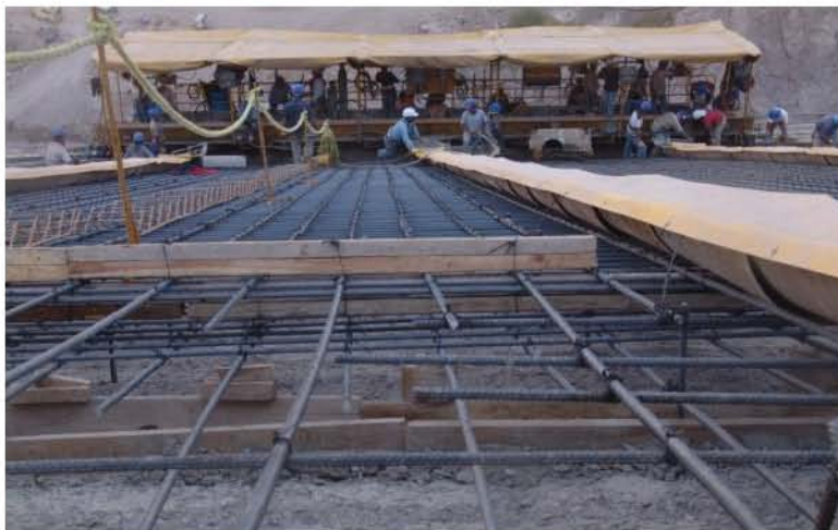
FIGURA II.48 COLADO DE LOSA EN LA CARA DE CONCRETO
