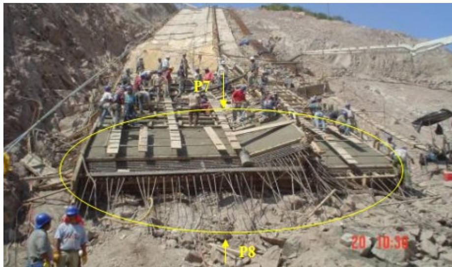
FIGURA II.43 COLOCACIÓN DE CONCRETO CON MOTOBOMBA ENTRE LOS PUNTOS P7 Y P8
