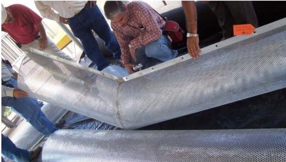
FIGURA II.52 HABILITADO EN TALLER DE LOS CAMBIOS DE DIRECCIÓN DE LOS CONTENEDORES
