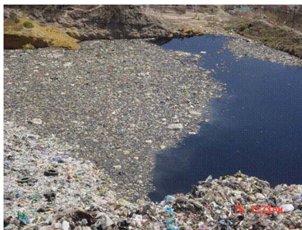
Figura 5.1. Laguna de lixiviados de un Relleno Sanitario
