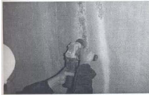
Fig. 5.14 Se retira el exceso de protuberancias (Trout, 2006)
