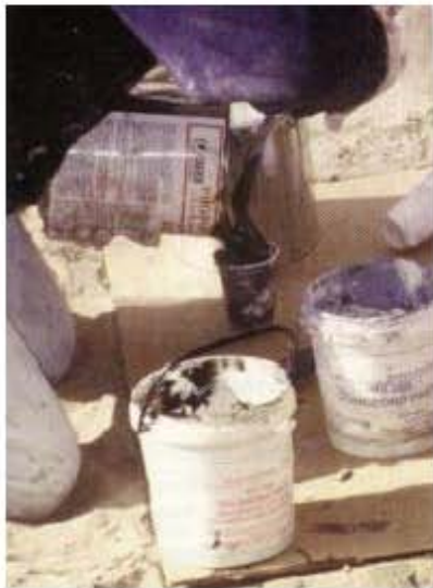
Fig. 5.36 Una preparación manual de la resina ocasiona mayores desperdicios (Trout, 2005)
