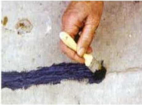
Fig. 5.17 Se utiliza una brocha para aplicar la capa de sellado (Trout, 2005)
