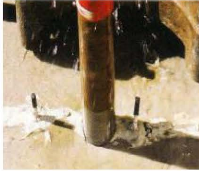
Fig. 5.39 Núcleos de concreto tomados después de terminar la inyección (Trout, 2005)
