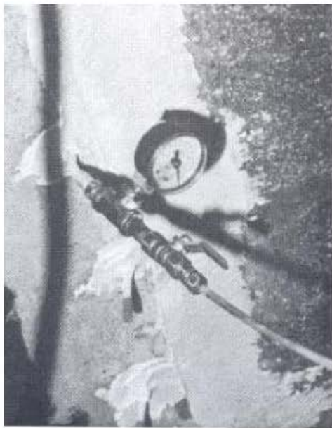
Fig. 5.31 El punto de rechazo ó cese del fluido en el puerto, se indica cuando la presión en la línea del surtidor se estabiliza (Trout. 2006)
