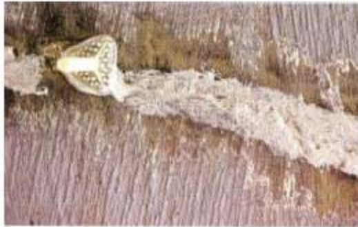
Fig. 5.18 Aplicación del sellador siguiendo puertos (Trout, 2005)
