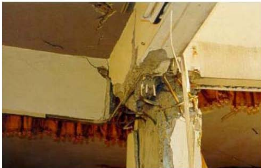
Fig. 2.9 Falla en uniones (Thermou y Elnashai, 2002)
