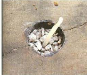
Fig. 5.28 Se coloca el tubo de inyección, la grava y se tapa el puerto con mortero epóxico (Trout, 2005)
