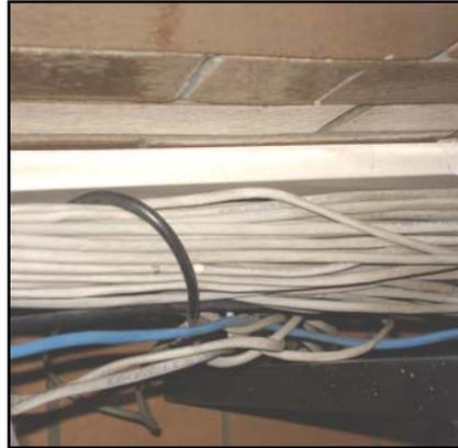
FOTOS 4.20 Y 4.21 CABLEADO DEL LABORATORIO 2 SIN CANALETA
