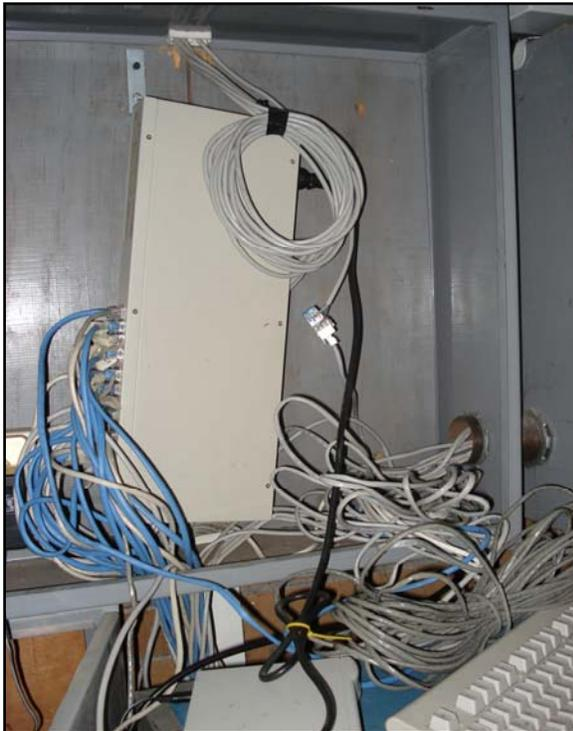
FOTO 4.15 HUB DE 24 NODOS PARA EL LABORATORIO 1
