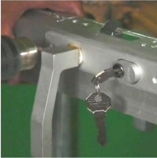
Una vez que se prueban las manijas y el funcionamiento del cerrojo se colocan las pijas y se aprietan los tornillos.
