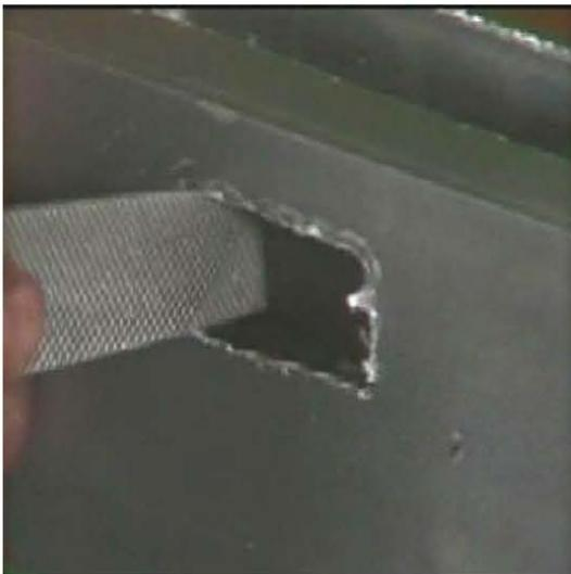
Se liman los bordes para eliminar cualquier tipo de residuo y rebaba que pueda afectar la instalación de los cuerpos.
