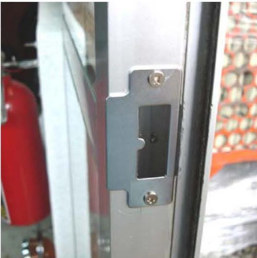
Se atornilla la contra con las pijas proporcionadas y se colocará a la misma altura que el mecanismo y cuidando que el resbalón se aloje libremente y que la contra obstruya el paso del pestillo de seguridad anti- tarjeta
