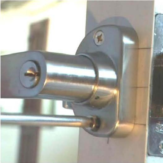
Se atornillan las manijas y se aprietan todos los tornillos para asegurar una instalación firme y rígida.
