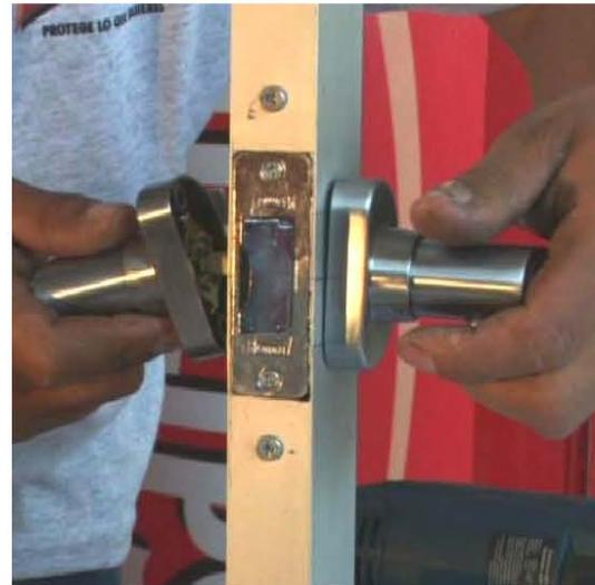
Se introducen las manijas cuidando de que los tornillos queden del lado interior del área a asegurar.
