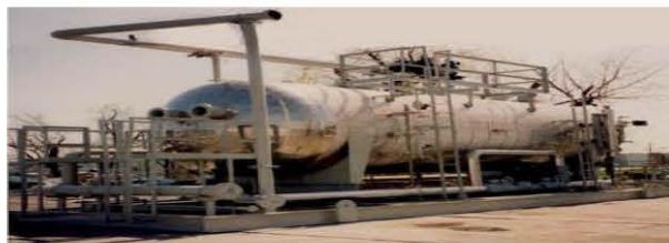
Figura 4.1 Instalación de una trampa para baches.
