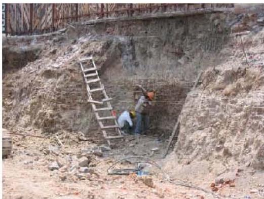
En la 3ª semana se dio inicio a los trabajos de lanzado en las ventanas donde ya se colocaron las anclas, para posteriormente hacer el tensado de las mismas. Una vez que están tensadas las anclas y lanzado el talud se procedió a bajar el nivel de excavación a -5.50mts. Para poder seguir abriendo las ventanas del lado de periférico, y a su vez llegar al primer nivel de anclaje de las flores.
