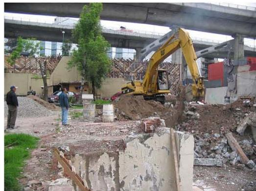
En la 2ª semana se termino la demolición de cimentación existente y se dio nivel al terreno a menos 3.30. Dejando talud de protección a colindancia y avenida periférico.
