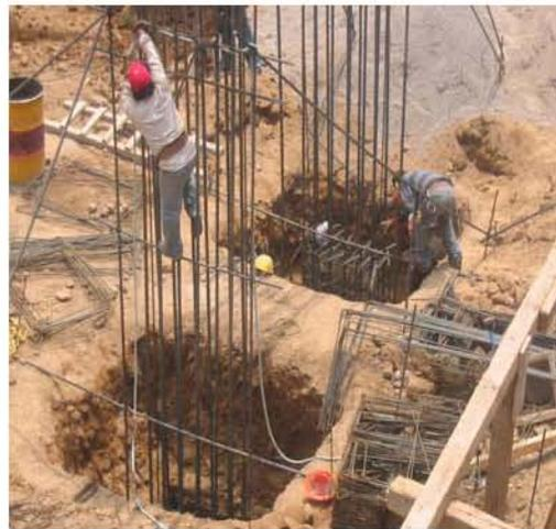
Es la 5ª semana y se hizo el habilitado y armado de columnas del nivel -7.05 de los ejes G, H, 6, 7, 9 y 11. y también se preparo cuatro juegos de cajones para columnas, para que esta semana se cuelen esas mismas cuatro columnas aparentes. Se continua con la excavación de zapatas aisladas del nivel -8.70 así como también las zapatas Z-12 y Z-13 del cubo de elevadores, para dar inicio al armado y habilitado, para así estar listos y recibir viga IPR que llegara la próxima semana.
