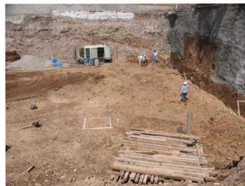
Esta es la 4ª semana y se continuo con la excavación en el área de la cisterna y hasta el eje 7 de (A - E) hasta dar nivel de desplante -8.70. Para dar terminación a la colocación de anclas en el eje de las flores del eje 7 al 12. También se inicio excavación en la esquina colindante del eje 1 con a para hacer retiro de cimentación existente, todo esto teniendo mucha precaución para no dañar la estructura del vecino, por tal motivo se solicito a impulsa hacer la demolición a mano.
