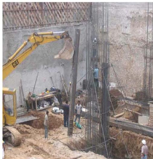
En la 6ª semana se realizó el descimbrado de muros MCA-1 del eje i de los ejes 6-12. Se comenzó a dar tramo en excavación de las zapata corrida del eje a de los ejes 4-9 y en las zapatas aisladas de los ejes 6-7 con ejes B-C. Se comenzó a cimbrar la zapata z - 12 del área de elevador y se continuó con el revestimiento del muro MCA- 1 del eje 12.
