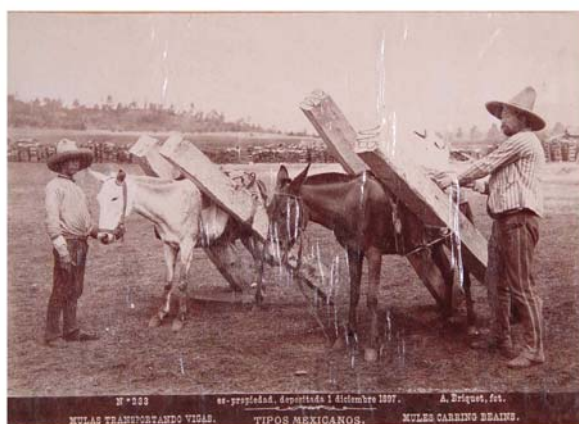
Foto 08-734266 Mulas transportando vigas. A. Briquet
