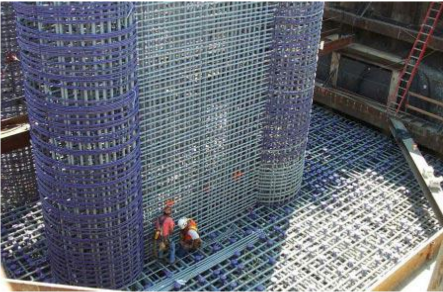
Imagen 5.8 Vista de la zapata octagonal y su columna para puente en California, USA
