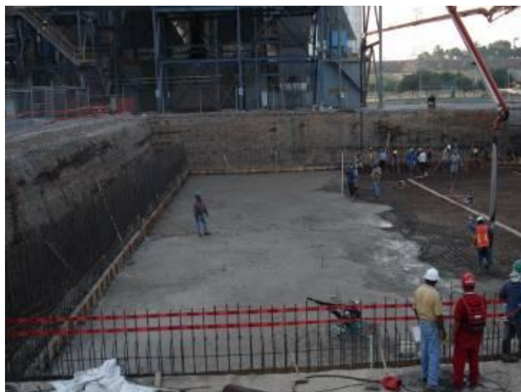
Imagen 5.1 Aspecto del colado de la base de la planta de sedimentación
