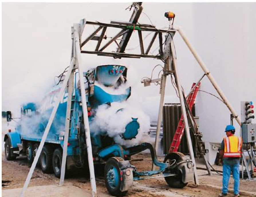
Imagen 4. Uso del nitrógeno líquido para el preenfriamiento del concreto
