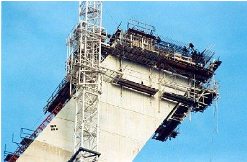
Imagen 5.6 Detalle de la construcción del mástil del Puente de la Unidad
