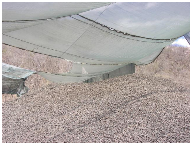
Imagen 4.2 Sombreado de agregados
