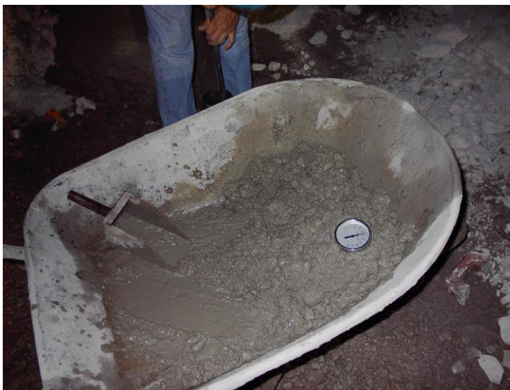
Imagen 5.4 Determinación de la temperatura del concreto previo al colado
