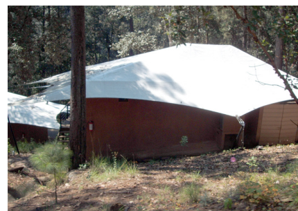
Las fibras textiles que se usan hoy ya están mejoradas y pre-impermeabilizadas con base en plásticos y resinas. La imagen muestra un bungalow del Hotel de Ecoturismo Río y Montaña en Valle de Bravo, Estado de México.
