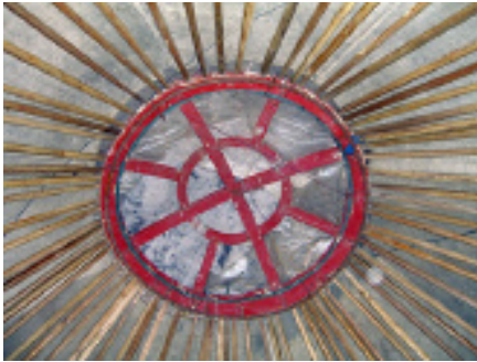
Centro del techo en el interior de las tiendas mongoles. Este agujero como el de los tipis regula la cantidad de viento que se necesita.
