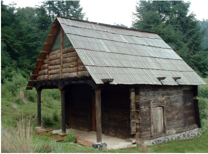
La Cabaña Prototipo totalmente construida con madera. Responde a la tipología tradicional de la zona.
