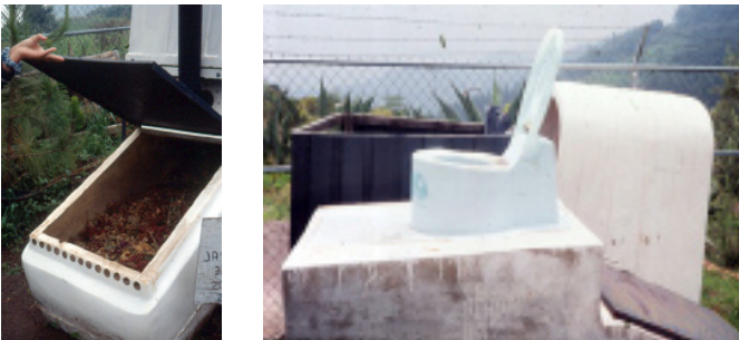
SIRDO (Sistema de reciclamiento de desechos orgánicos), una alternativa en las comunidades para el tratamiento y depósito de los desechos orgánicos. En la imagen se muestra un SIRDO seco.
