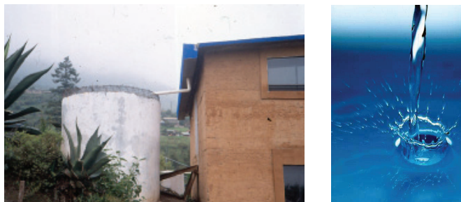
Depósito de agua realizado con ferrocemento para captación pluvial en una comunidad de Huixquilucan. El agua es un recurso indispensable para la vida.
