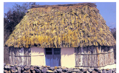
La casa tradicional maya hecha con bahareque y paja, una de las arquitecturas que mejor se adapta a su clima. Yucatán, México.
