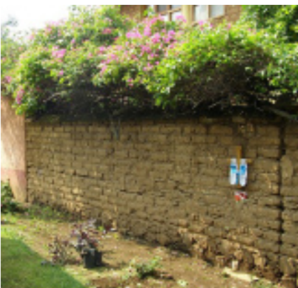
Una barda de adobe del siglo pasado muy común en el paisaje Mexicano. Malinalco, Morelos.
