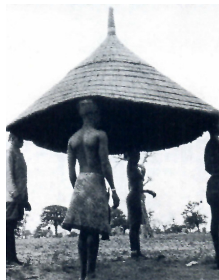
Las construcciones con fibras leñosas son muy antiguas, contienen la característica de ser lo suficientemente ligeras. Ideales en climas cálidos debido a que dejan pasar el viento. En la imagen se muestra una vivienda portátil de Chad, Africa.
