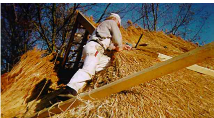
Las techumbres de paja también tienen propiedades térmicas, pueden ser usadas en climas fríos también como doble piel.
