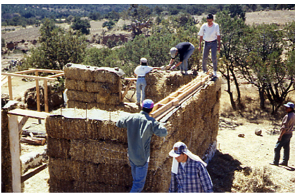
Las viviendas con este material son fáciles de construir y con material ligero y térmico. Aquí se muestra una casa en construcción.
