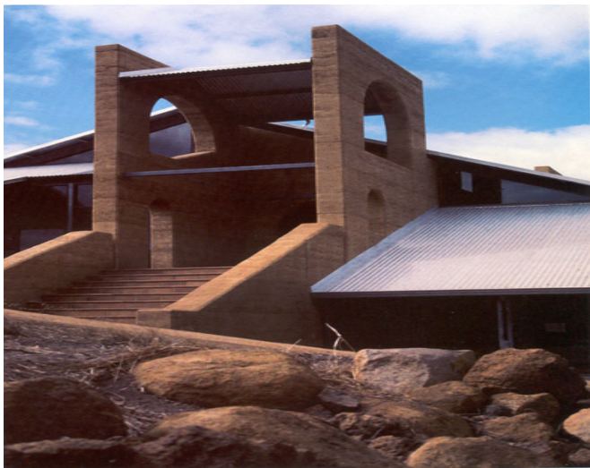
Casa en Nuevo México, los muros de carga son de tierra compactada debido a la resistencia y masividad.
