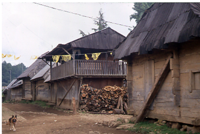
Trojes Michoacanas del pueblo de San Isidro. Una arquitectura ideal para clima frío-húmedo. Se vive en el cajón inferior y el amortiguamiento está en los muros de madera y el techo, donde se almacena el grano de la cosecha.
