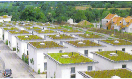
Un conjunto de casas obreras en Alemania. Los techos naturados además de ser aislantes hacia el interior de las habitaciones, ayudan a mejorar el efecto isla de calor en las ciudades.
