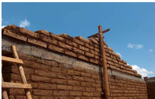
Ilustración 7. Construcción del bachillerato.
