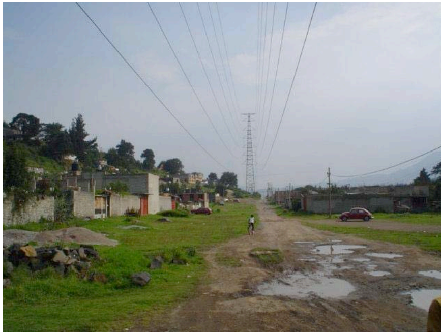
Figura 9.11. Condiciones fuera de norma con relación al derecho de vía de las líneas de transmisión de energía eléctrica en la colonia Las Torres.
