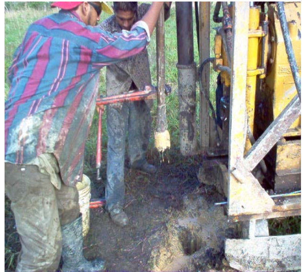
FOTO 6.- BROCA TRICÓNICA DESPUES DEL AVANCE
