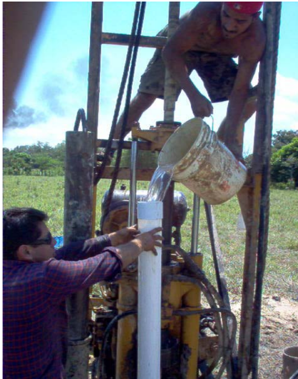
FOTO 22.- LLENADO DE TUBERIA DE PVC HIDRÁULICO PARA ESTUDIO GEOFÍSICO DOWN HOLE
