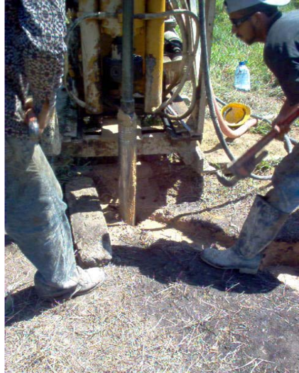
FOTO 14.- EXTRACCIÓN DE TUBO SHELBY (TS) DEL SM 2
