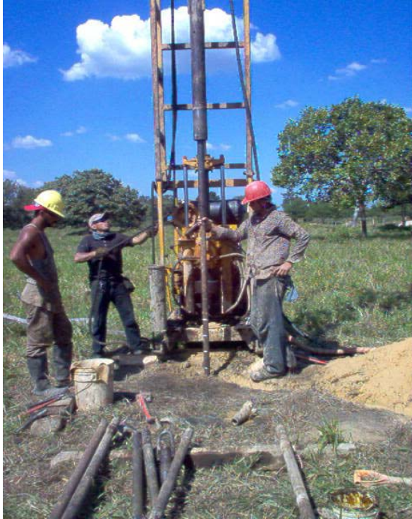
FOTO 13.- VISTA FRONTAL DEL SONDEO DE PENETRACIÓN ESTANDAR (SPT)
