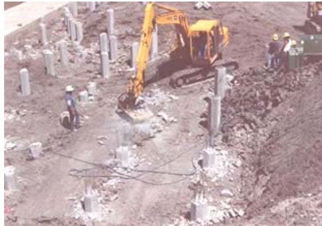
Figura IV.3 Cimentación a base de Pilotes.
