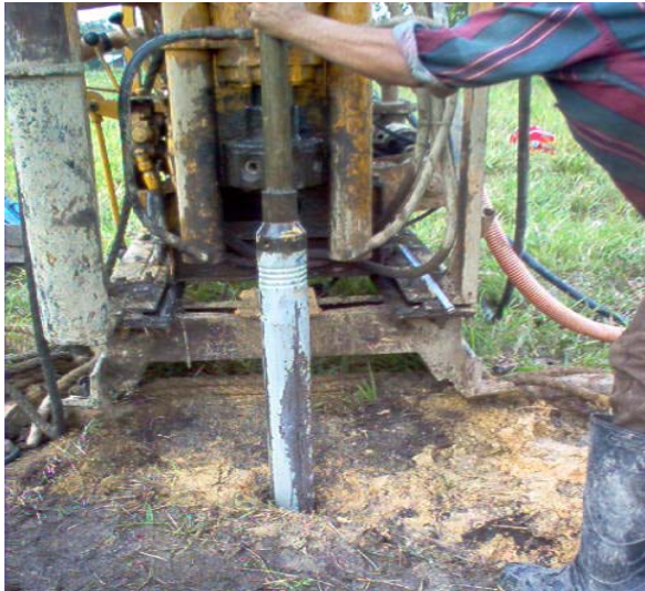
FOTO 9.- EXTRACCIÓN DE TUBO SHELBY (TS) DEL SM 1
