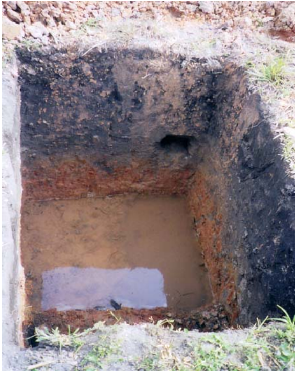
FOTO 17.- VISTA GENERAL DEL POZO A CIELO ABIERTO N° 1
