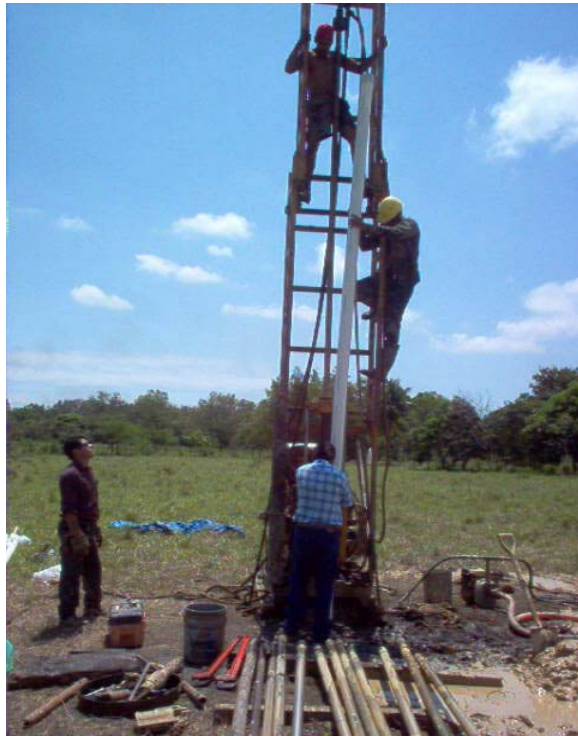
FOTO 21.- INSTALACIÓN DE TUBERIA DE ADEME PARA ESTUDIO GEOFÍSICO DOWN HOLE
