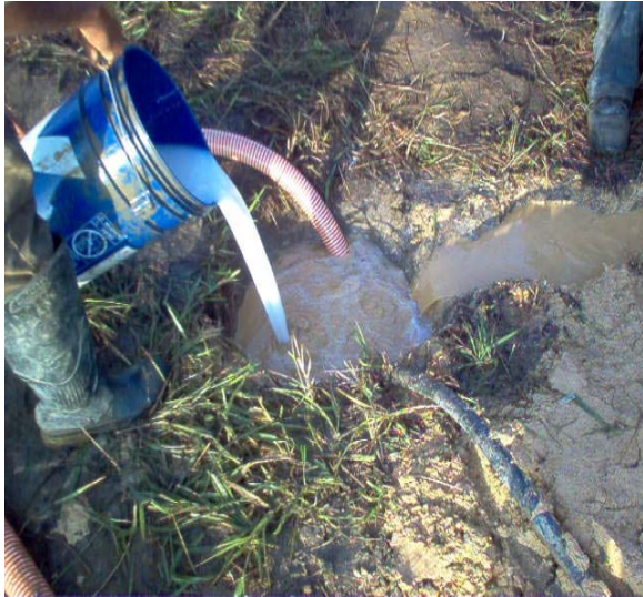
FOTO 5.- SUMINISTRO DE FLUIDO DE PERFORACIÓN
