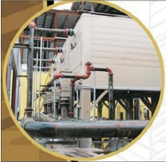
Figura 11 Torres de Enfriamiento Modulares
