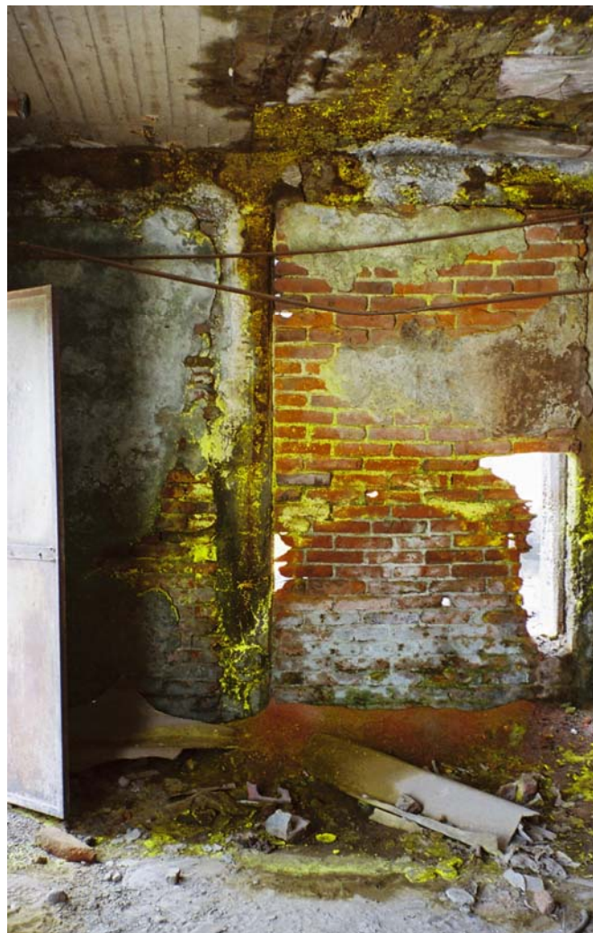
Figura 11. Contenedor, las fisuras permiten ver el polvo amarillo característico
