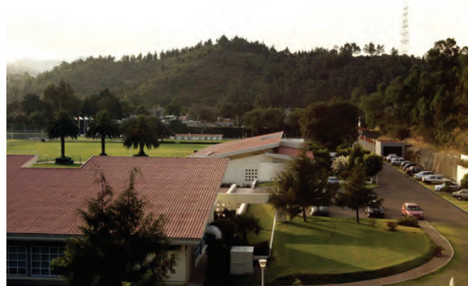
Centro de Alto Rendimiento (CAR)
