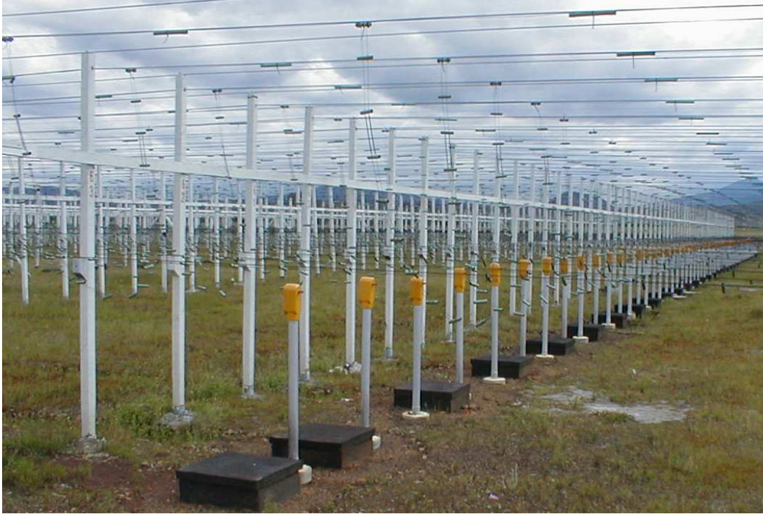
Figura 3.7: La infraestructura para el sistema de amplificación de campo del arreglo dipolar se integra con registros de concreto comunicados por un sistema de tuberías. Se tienen 128 registros desplegados en el área de la antena.
