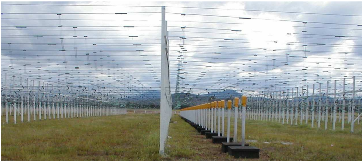
Figura 2.8: El arreglo dipolar del MEXART. Se aprecia la estructura de soporte, los dipolos, líneas de transmisión, y algunos registros del sistema de amplificación.
