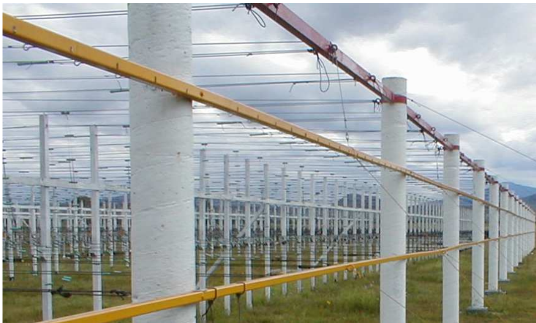
Figura 3.5: El sistema de soporte del arreglo dipolar: columnas de concreto interconectadas por estructuras metálicas y el sistema de tensores.
