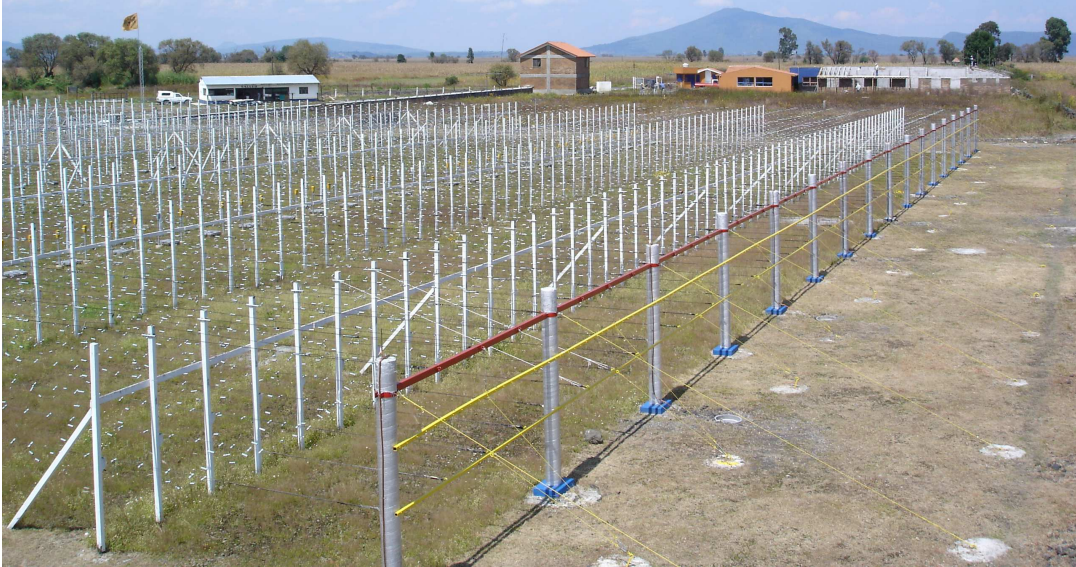
Figura 3.4: Vista panorámica del Observatorio de centelleo interplanetario. En primer plano se aprecia el arreglo dipolar, en un segundo plano se aprecian los laboratorios, el cuarto de control, y el área de cubículo.
