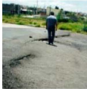
**Figura 3.2.1.6.** Hundimiento local y agrietamiento del subsuelo.
