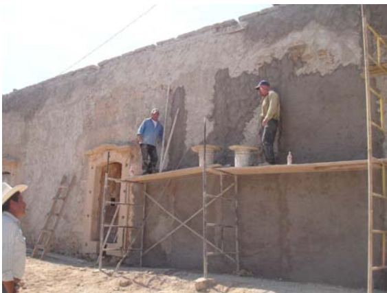
repellado: se prepara mortero porción 2:5 cal:arena
