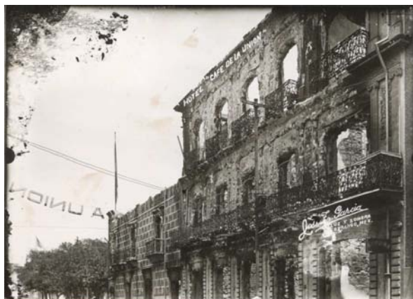
Edificio del Café Union, también incendiado en la ciudad de Durango. *
