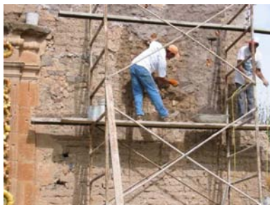
Colocación de aplanados en adobe
