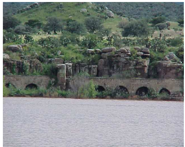
Acueducto ex hacienda de la Ochoa*
