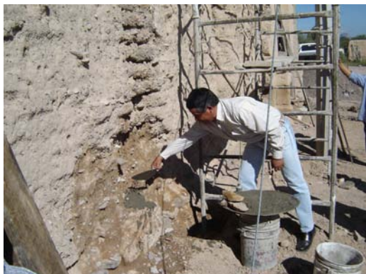
Reposición de adobe en fachada
