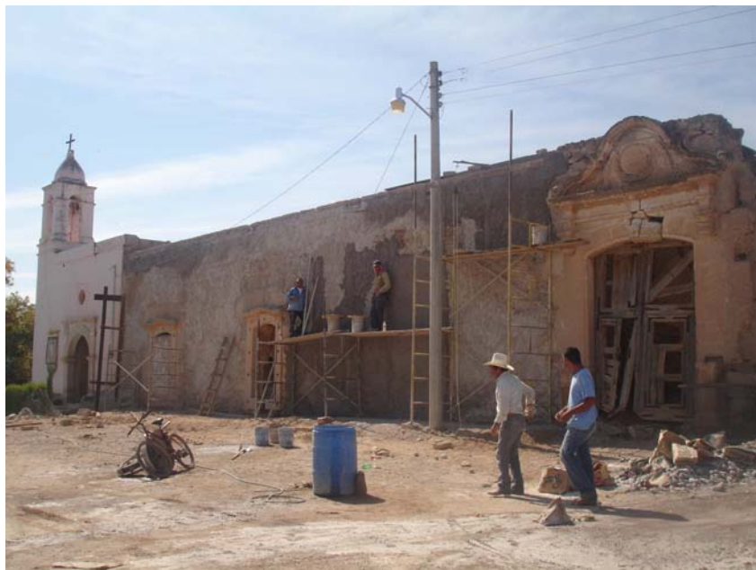
Trabajos de restauración en fachada de ex hacienda
