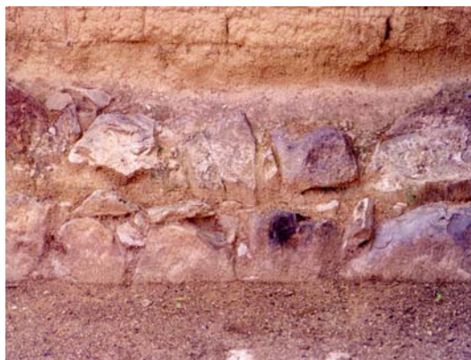
Cimiento en muros de adobe del real de minas de Vacas, Nombre de Dios
