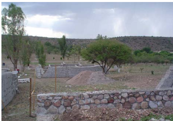
Cimentación de piedra rodada, del río de San Juan
