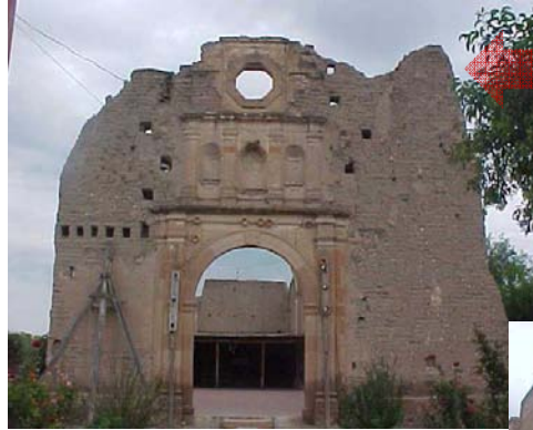
Hilada de ladrillos en parte superior de muros
