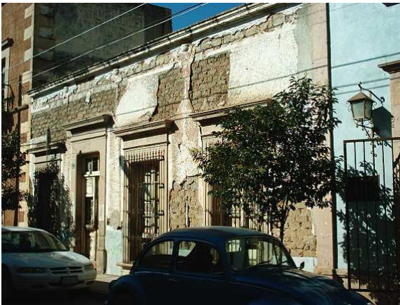
Monumento histórico calle Francisco I. Madero
