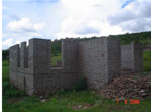
Muros de adobe colocados
