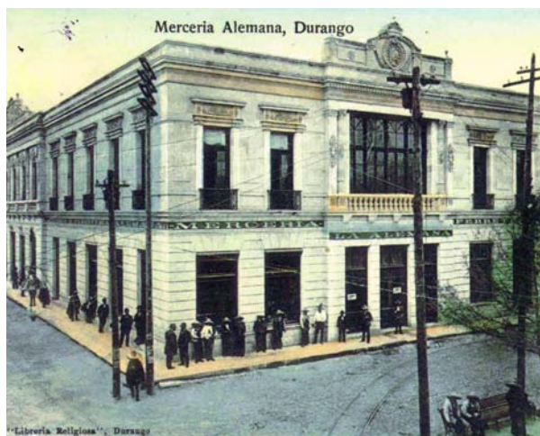
“Mercería Alemana”, edificio porfiriano demolido
