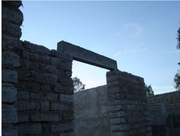
Dintel de concreto armado en cerramiento puerta
