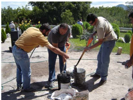
Preparación del mortero cal-arena
