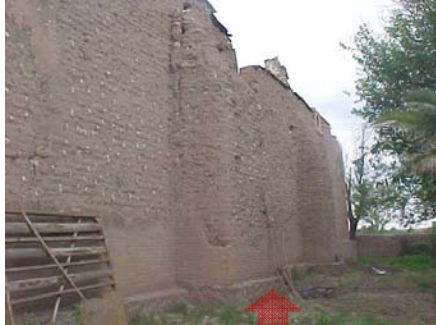
Recimentación de muros con cemento de piedra de 60 cms de ancho por 70 cms de profundidad a cada 60 cms de espaciamiento
