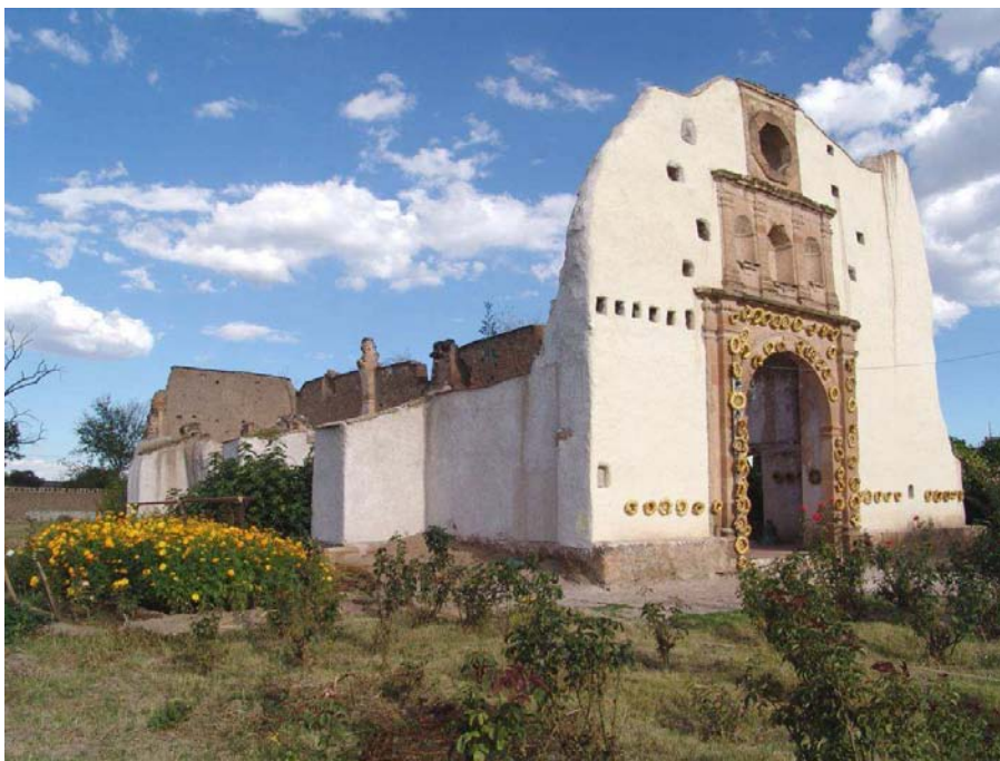
Obra consolidación templo de San Francisco Nombre de Dios*
