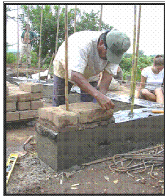
Figura 19. - Colocación del Refuerzo de Caña en El Salvador (Dowling, 2002)
