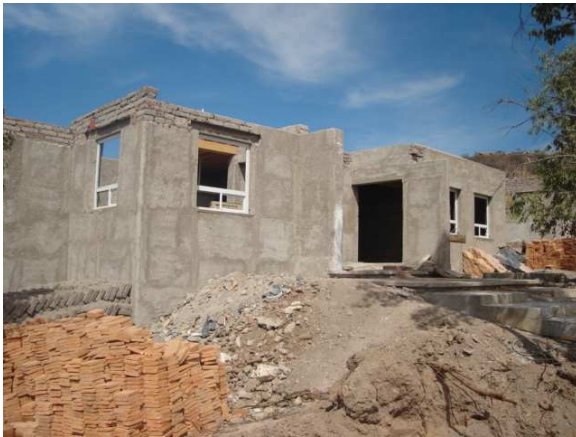
Aplanados de cal-arena en muros de adobe
