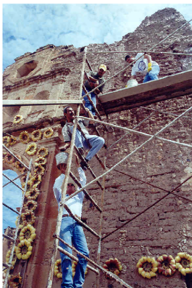
Apuntalamiento fachada templo
