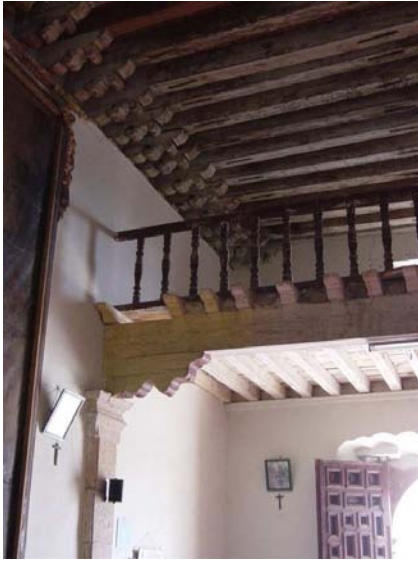
Cubierta de vigas de madera en el templo, Jesús de Nazareno, Nombre de Dios, Dgo.
