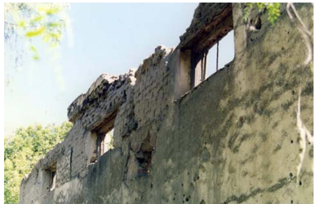
Ventanas del templo del Real de Minas de Guarisamey
