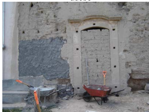
Aplanado de mortero en fachada
