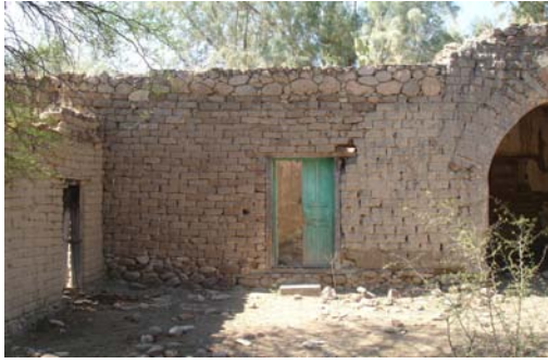
Cadena de piedra bola en vivienda Agua Zarca
