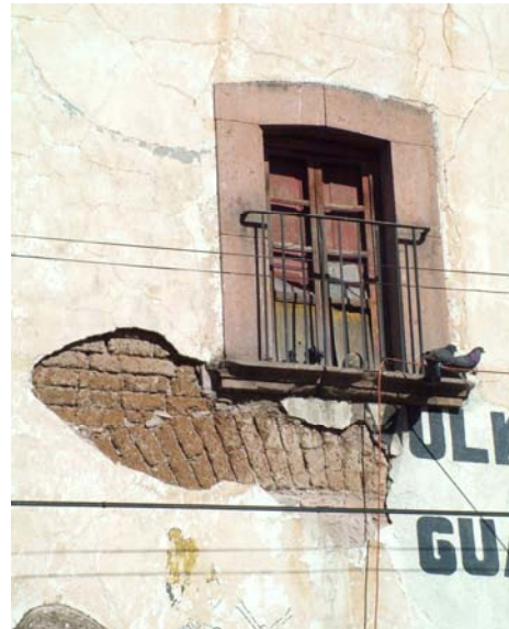
Arco de descarga para segundo piso *
