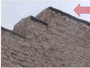
Hilada de ladrillos en parte superior de muros
