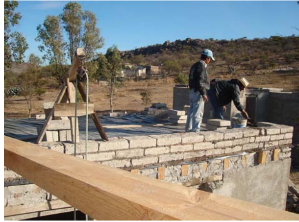
Cubierta a base de vigas de madera pino
