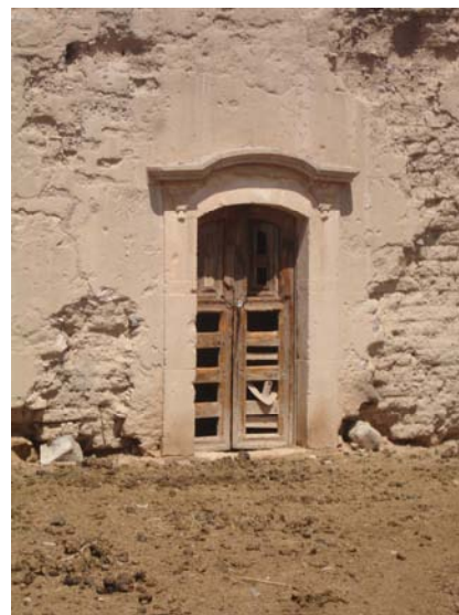
Marcos de puertas con cantera labrada
