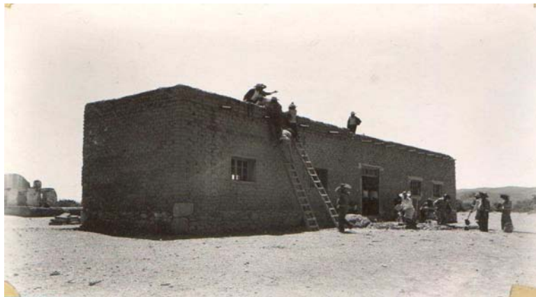
Construcción de cubierta escuela de Santa Cruz, La Cuchilla Durango *
