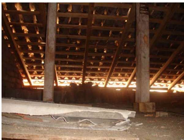
Estructura de madera para cubierta de teja
