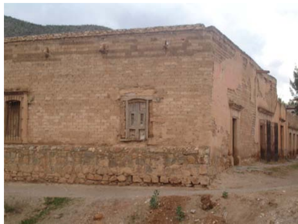
Vivienda de adobe con cimiento de mampostería
