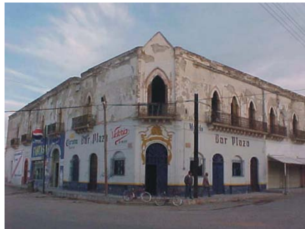
Edificios del Real de minas de Mapimí
