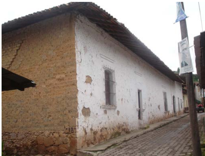
Vivienda de adobe con alero amplio para protección (municipio de Canelas)
