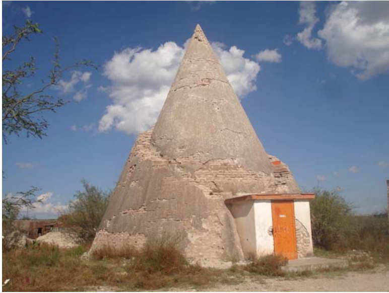
Silo de adobe, Yerbanis municipio de Cuencame
