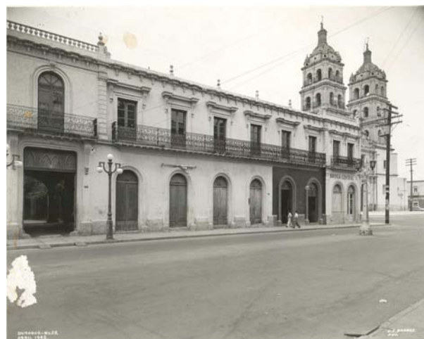
Edificio construido para sustituir el anterior
