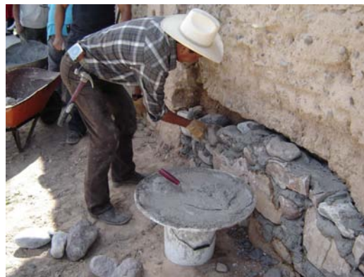
Cimentación de piedra recibiendo muro de adobe
