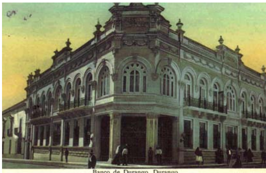
Edificio del Banco de Durango, demolido en los cincuentas
