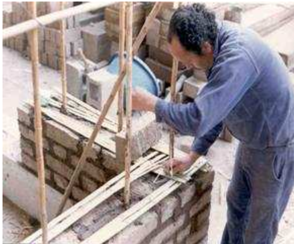
Figura 18. - Colocación del Refuerzo de Caña en Perú (Blondet y otros, 2002)
