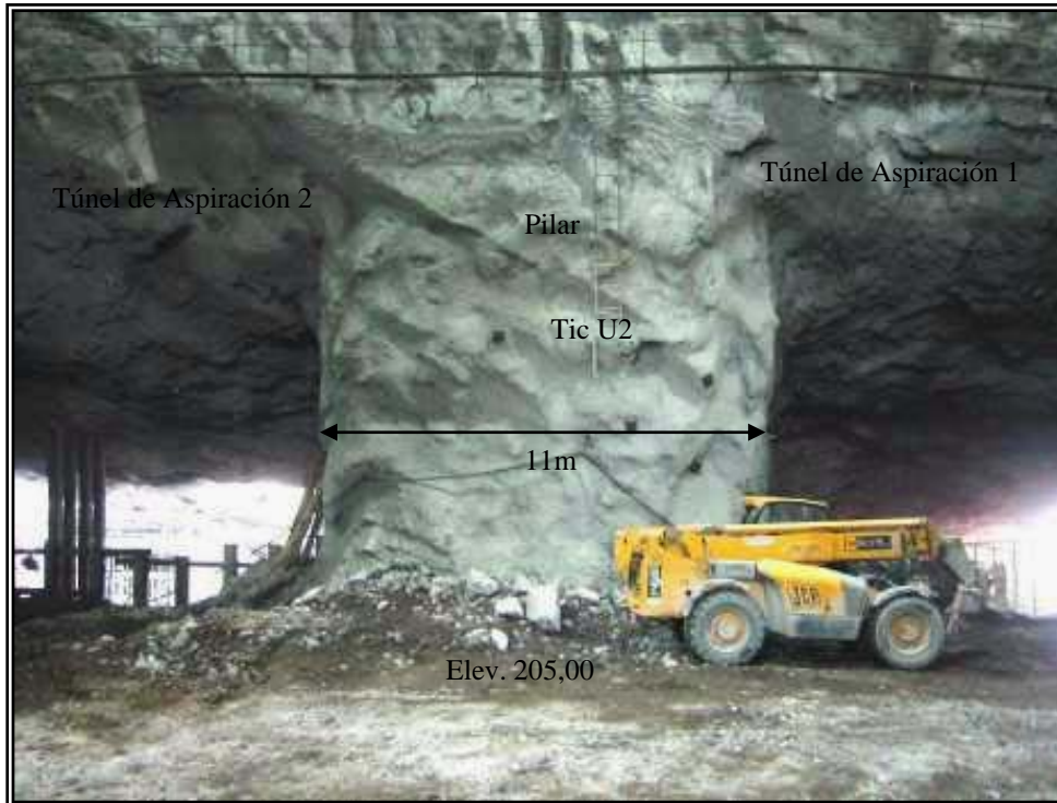
Fotografía 15. Vista hacia aguas arriba del pilar de roca que separa los dos túneles de aspiración, al fondo se nota la comunicación con la casa de máquinas
