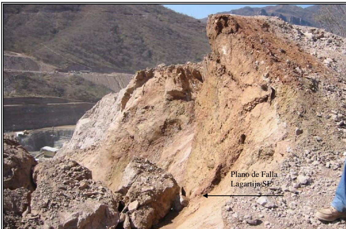
Fotografía 25.- Vista del plano de la Falla Lagartija SE que provocó el derrumbe, obsérvese la roca alterada e intemperizada.
