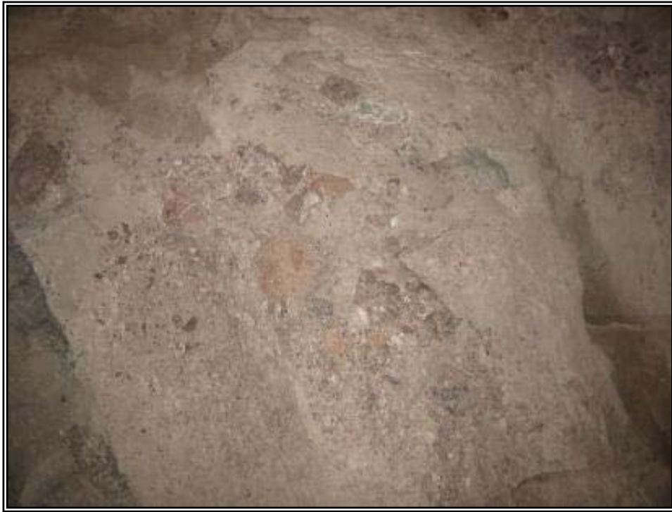
Fotografía 8. Vista de la tubería a presión 1 en el cadenamamiento 0+060,00 donde se observa con detalle las características del horizonte aglomerático inferior de la fase ignimbrítica de la unidad TicU2
