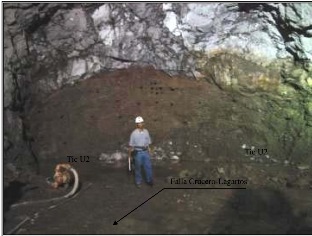
Fotografía 5. Aspecto de la falla Crucero-Lagartos en la parte oscura del frente de la excavación, en la parte superior se notan los fragmentos del aglomerado intermedio de la Unidad 2
