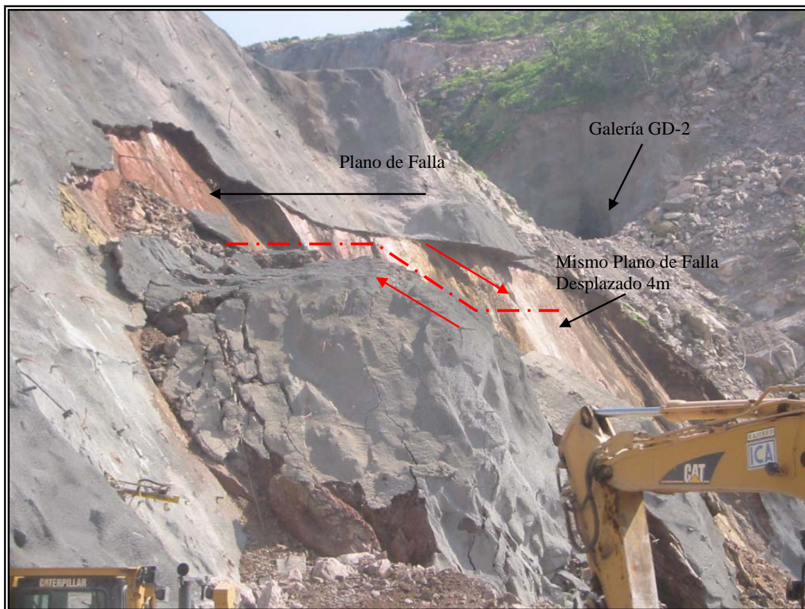
Fotografía 27.- Vista del derrumbe ocurrido entre la subestación y el camino 7-MD (elev. 340,00 a la 311,00). Nótese la zona del plano de la Falla Lagartija SE desplazada 4m hacia el frente por una de las fallas-dique.
