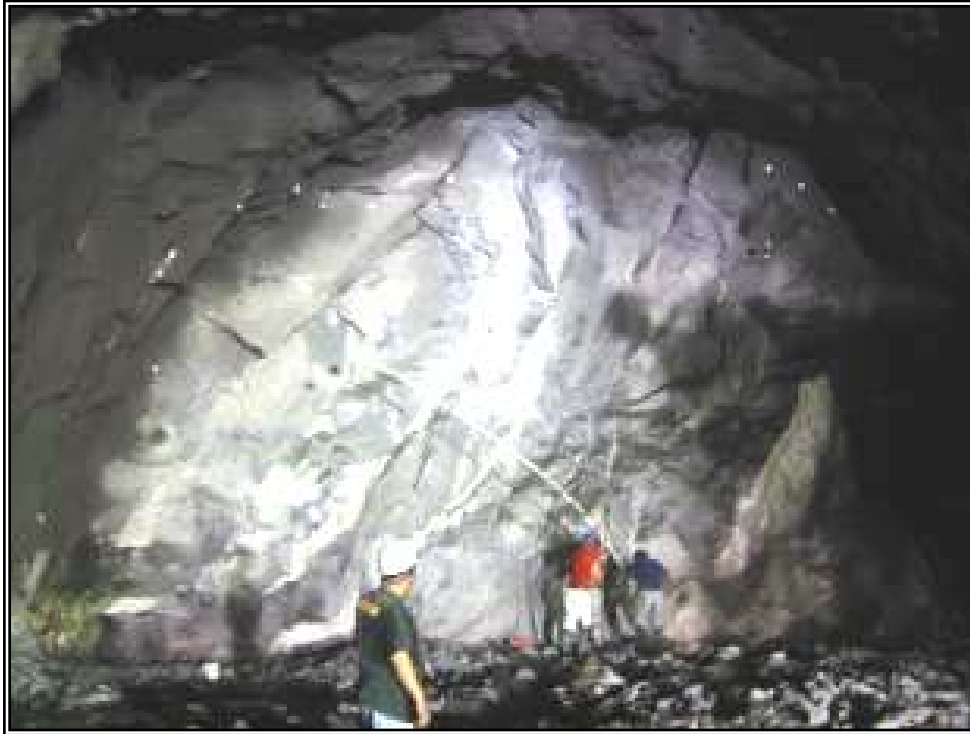
Fotografía 19.- Vista del túnel de desfogue por la media sección superior en el cadenamiento 0+254,00 donde se observa el aspecto masivo de la roca y el escaso fracturamiento, en esta zona, con relleno de calcita.
