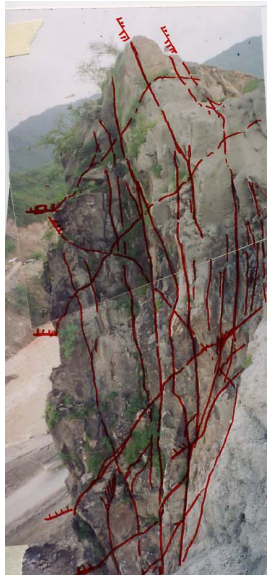
Fotografía 22.- Vista hacia aguas abajo del cantil de la parte superior de la salida del desfogue, donde se aprecia el intenso fracturamiento del macizo rocoso y su fuerte proceso de relajamiento de su borde superior (problema independiente a la estabilidad general del macro bloque).
