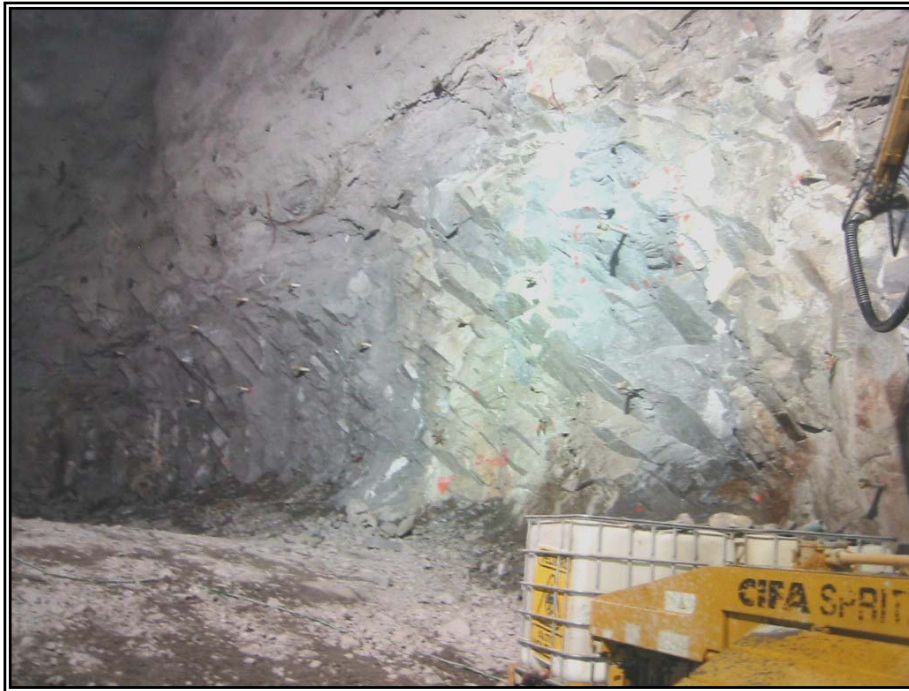
Fotografía 18. Pared de aguas arriba de la galería de oscilación a la elevación 211,00 donde se aprecia la disposición de las fracturas, su frecuencia, orientación e inclinación hacia dentro de la pared y lo cerrado de éste.
