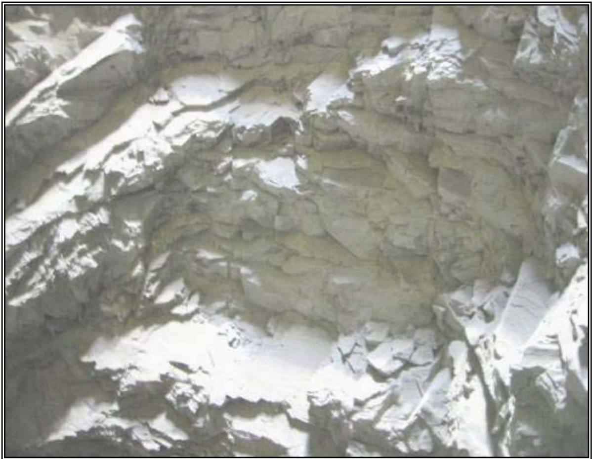
Fotografía 23.- Vista de la pared de la lumbrera de buses 1, a la elevación 283,50 en donde se observa la orientación del sistema del fracturamiento principal.
