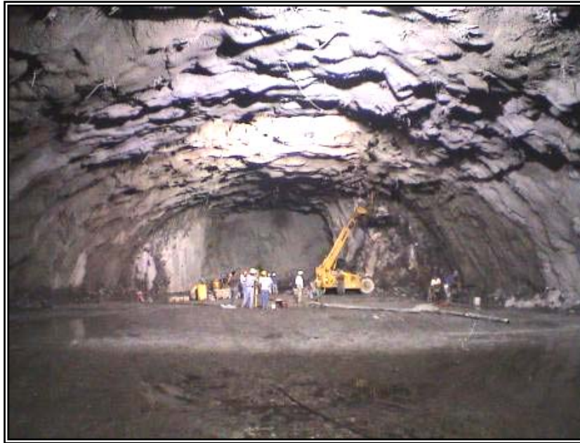
Fotografía 11. Excavación de la bóveda de la casa de máquinas donde se aprecian las características de la roca
