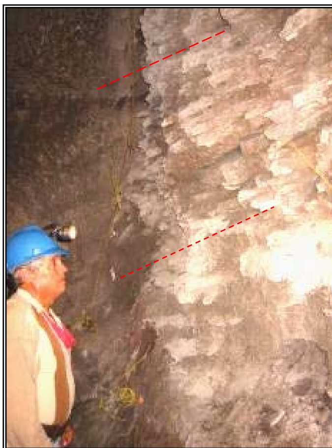
Fotografía 2. Fracturamiento denso que se asocia a la Falla Crucero-Lagartos
