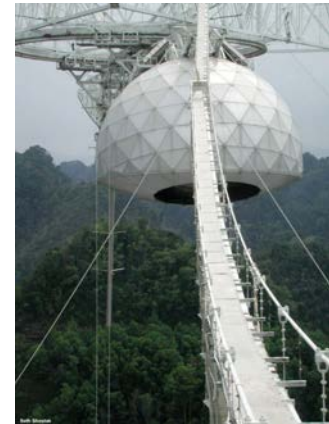
Fig. 4.15- Radar-telescopio gigante ubicado en Arecibo Puerto Rico, con reflector principal esférico de 305m de diámetro. Es empleado para aplicaciones de astronomía, en el estudio de cuerpos celestes.
