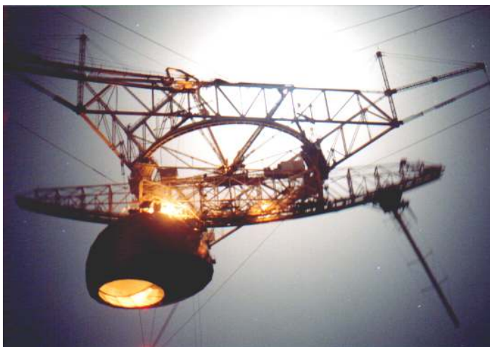
Fig. 4.15- Radar-telescopio gigante ubicado en Arecibo Puerto Rico, con reflector principal esférico de 305m de diámetro. Es empleado para aplicaciones de astronomía, en el estudio de cuerpos celestes.
