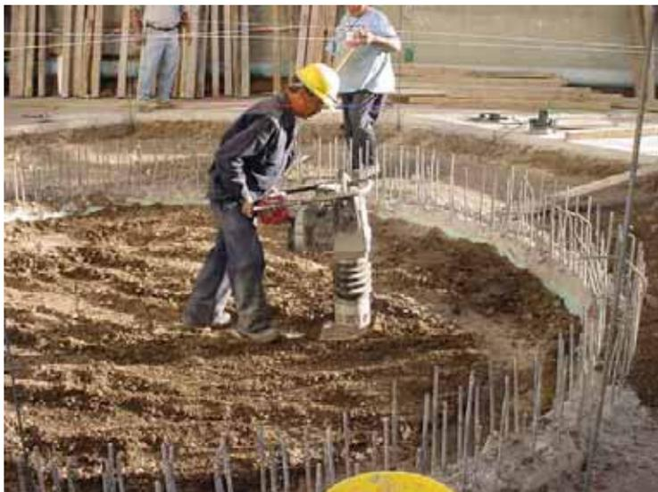
Figura C.2 Relleno y compactación al 90% de la prueba Proctor estándar en base de filtro percolador.
