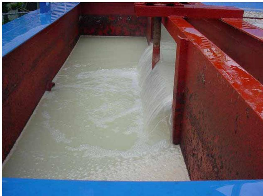
Figura C.16 Agua residual después de la separación de grasas en el Sistema de Flotación por Aire Disuelto (Dissolved Air Flotation DAF)
