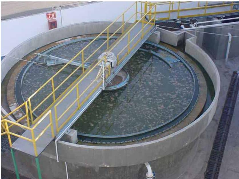
Figura C.18 Filtro Sedimentador en funcionamiento.
