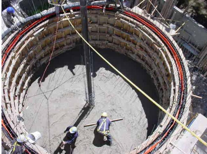
Figura C.7 Colado de elementos del filtro percolador.
