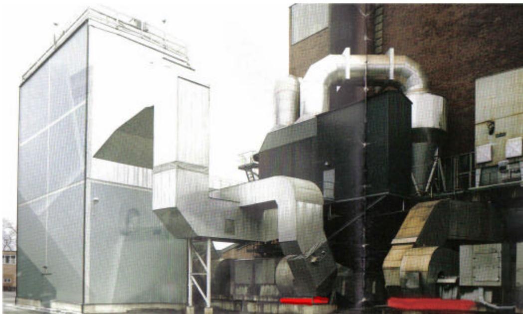
Fig. 8 Ventiladores industriales(rojo) para la extracción de humos en la industria acerera.
