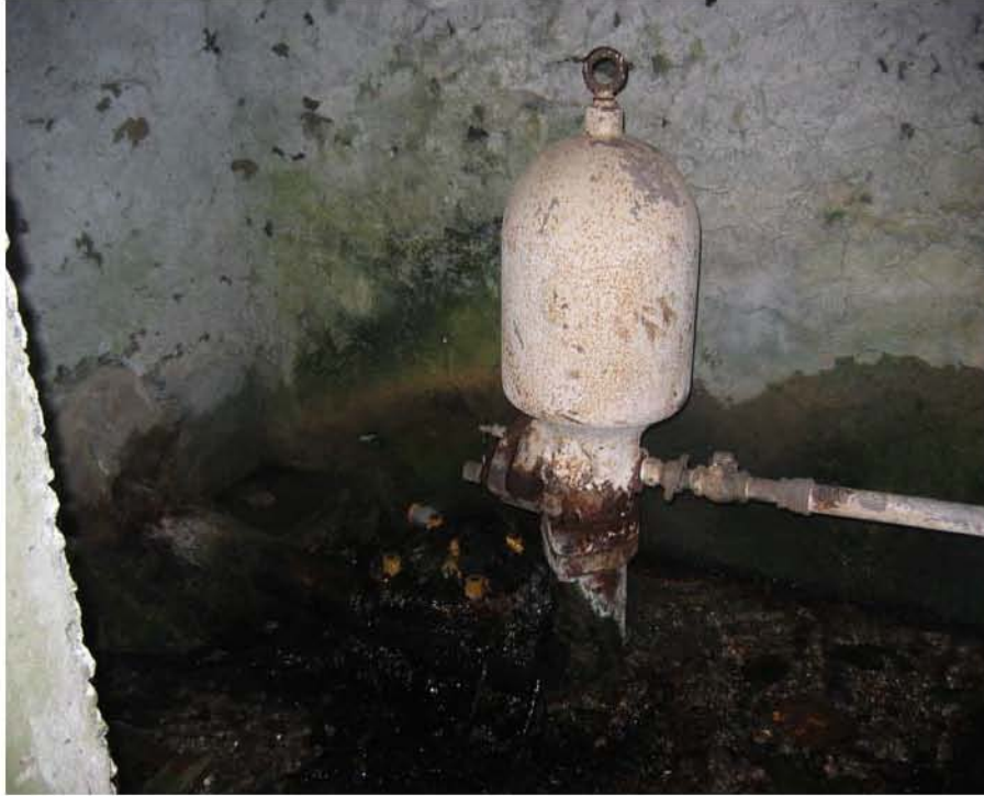
FIGURA No. 3 Ariete que suministra de agua a la comunidad de los Atlixcos con tubo de alimentación de 4" y tubo de salida de 2" de diámetro
