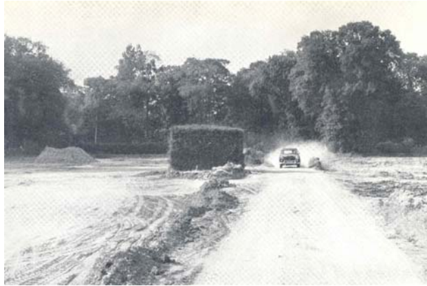
Figura 69. Trabajos realizados durante la construcción.
