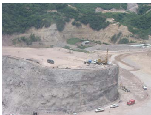
Figura 10.1-1. Muro alabeado y talud izquierdo del vertedor de excedencias.
