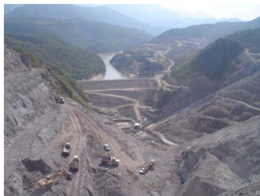
Figura 8. Caminos asociados para la construcción.
