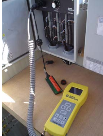
Figura 3.3-5. Medición de los extensómetros eléctricos.
