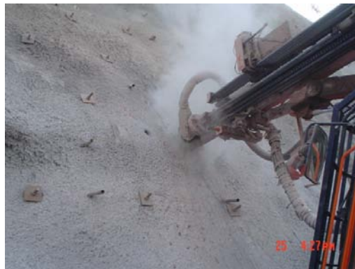
Figura 8.2-1. Perforación del barreno con equipo de percusión.
