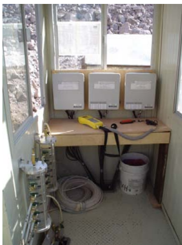
Figura 5.3-1. Medición del nivel de agua de la cimentación y cuerpo de la cortina con la unidad de medición DataMate MP.
