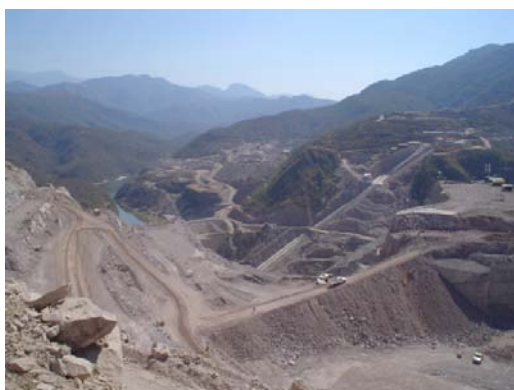
Figura 10.1-3. Retiro de material de mala calidad correspondiente a la falla arroyo en el muro alabeado y talud izquierdo del vertedor de excedencias.
