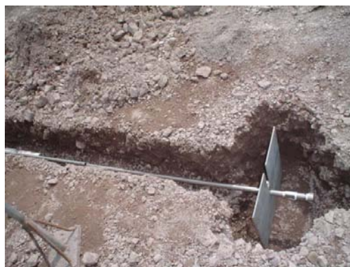
Figura 3.2-1. Instalación de un extensómetro eléctrico de placa sobre el terraplén.
