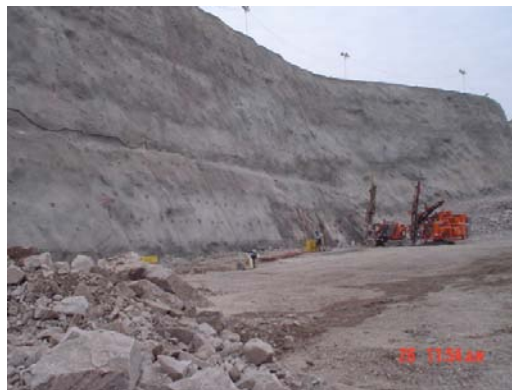
Figura 10.3-1. Talud sobre la subestación y el camino de construcción 7MD.
