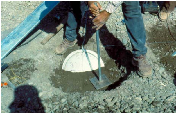
Figura 4.2-1. Instalación de celdas de presión total con transductor de cuerda vibrante.
