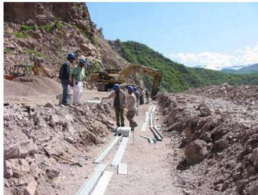
Figura 7.2-1. Zanja para alojar los instrumentos y tubos de los NHA.
