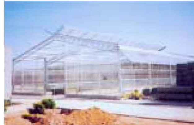
Invernadero de doble vertiente Cubierta de vidrio y estructura metálica Foto: desconocido
