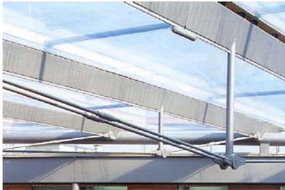
Cubierta de Policarbonato Sobre estructura viga cable Foto desconocido
