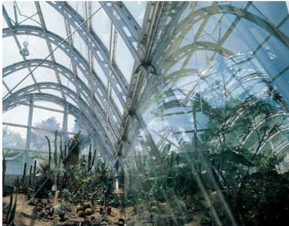
Invernaderos del Instituto de Botánica de la Universidad de Graz, Austria arquitecto : Volker Giencke
