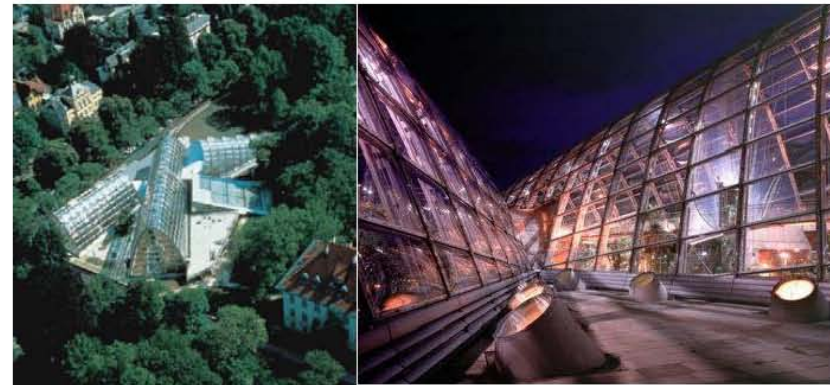
Invernaderos del Instituto de Botánica de la Universidad de Graz, Austria arquitecto: Volker Giencke
