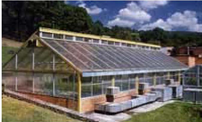
Invernadero Venlo Foto: Néstor Zamudio
