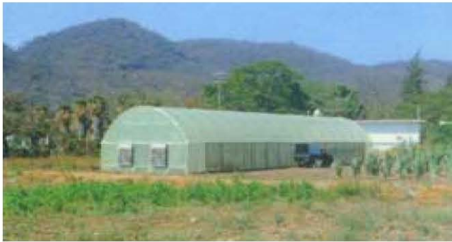
Invernadero curvo comercial Cubierta de plástico y estructura metálica Foto: Francisco Vidal
