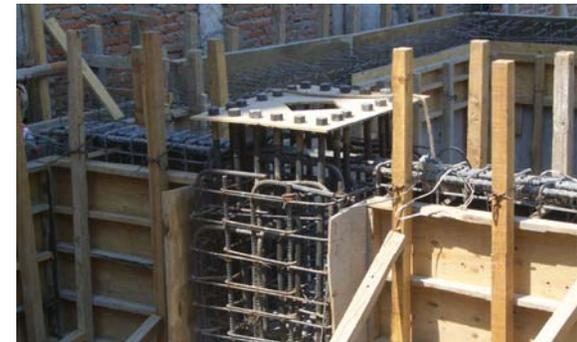
Armado de muros y dados de cimentación en cisternas.
