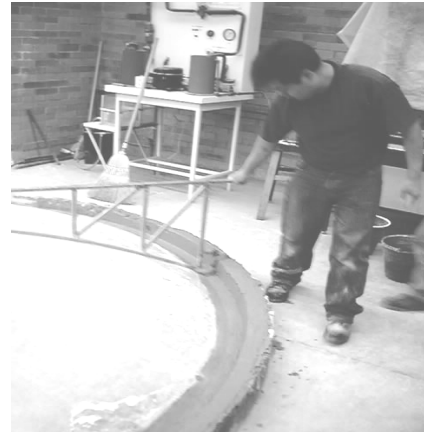
Secuencia 4. Acabado de la superficie: alisado, lijado, pintado y pulido con cera.
