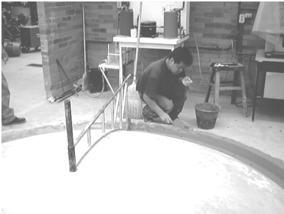
Secuencia 4. Acabado de la superficie: alisado, lijado, pintado y pulido con cera.
