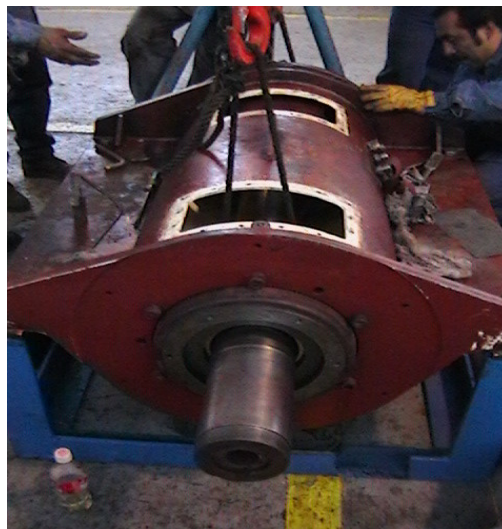
Figura. 4.6 Desmontaje del conjunto de cojinetes
