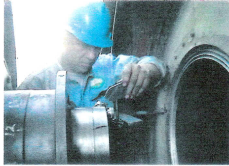
Figura. 5.2 Montaje y alineación del servomotor
