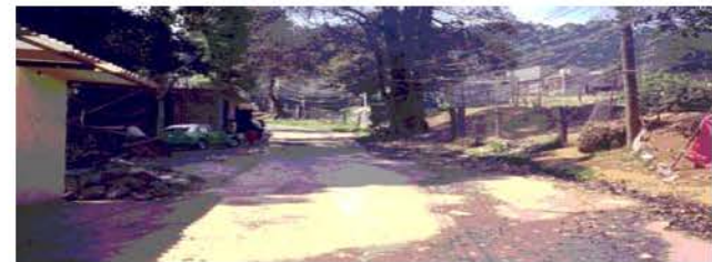
Vista Nortede la Av. Jacarandas dirección Carretera Ajusco
