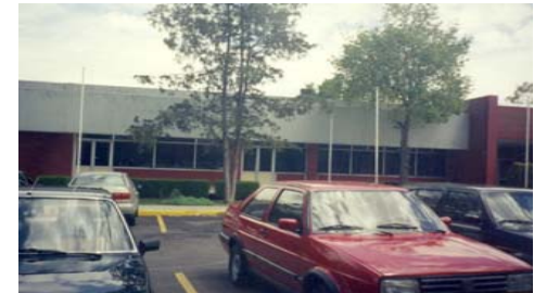
Fachada principal del CENDI C.U.
