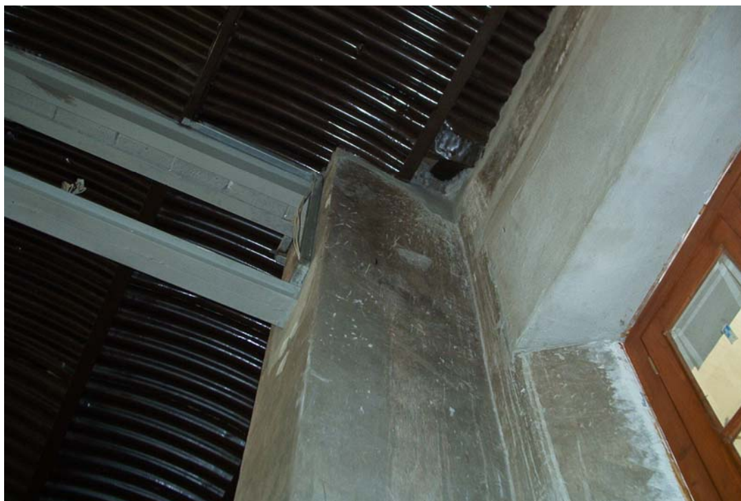
Figura A2.16. Elementos de concreto reforzado en la intervención del edificio del Antiguo Palacio de Odontología, hoy Palacio de la Autonomía de la UNAM. Fuente propia.
