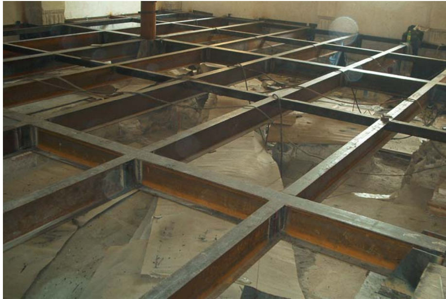
Figura A2.19. Vigas de acero usadas para un piso en el proceso de restauración del Palacio de Odontología. Fuente propia.
