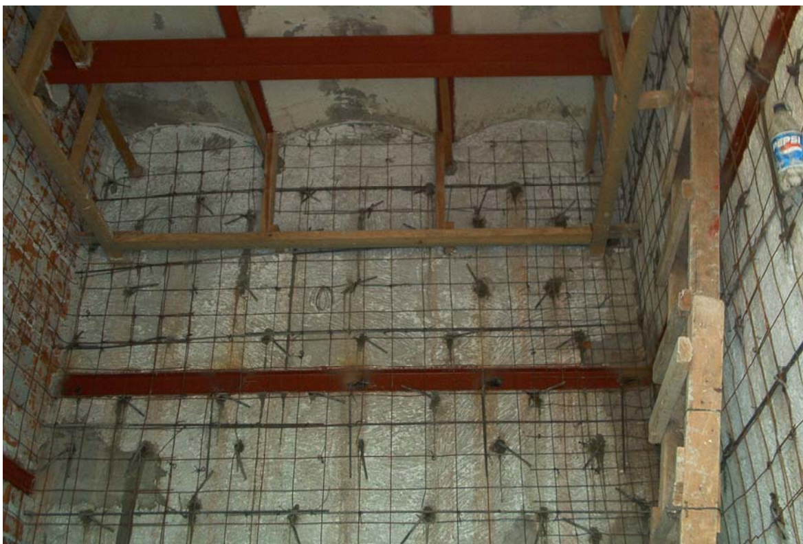
Figura A2.22b. Aspecto del nuevo muro de concreto armado que se construyó en el proceso de restauración del Antiguo Palacio de Economía. Fuente propia.
