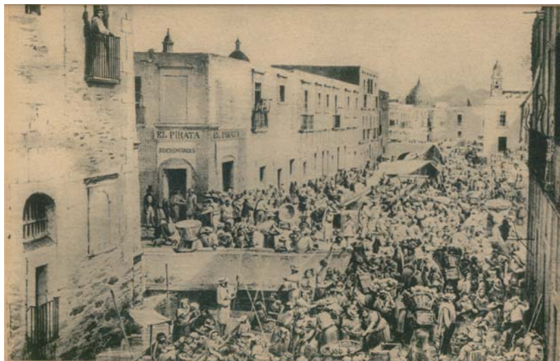
Figura 3.11 Vista del centro histórico de la ciudad, en donde se aprecia las construcciones bajas con las que se desplantó toda esta zona, con estructuras de mampostería y sistema de entrepiso de muros y vigas. Imagen: México en el tiempo. Fisonomía de una ciudad.
