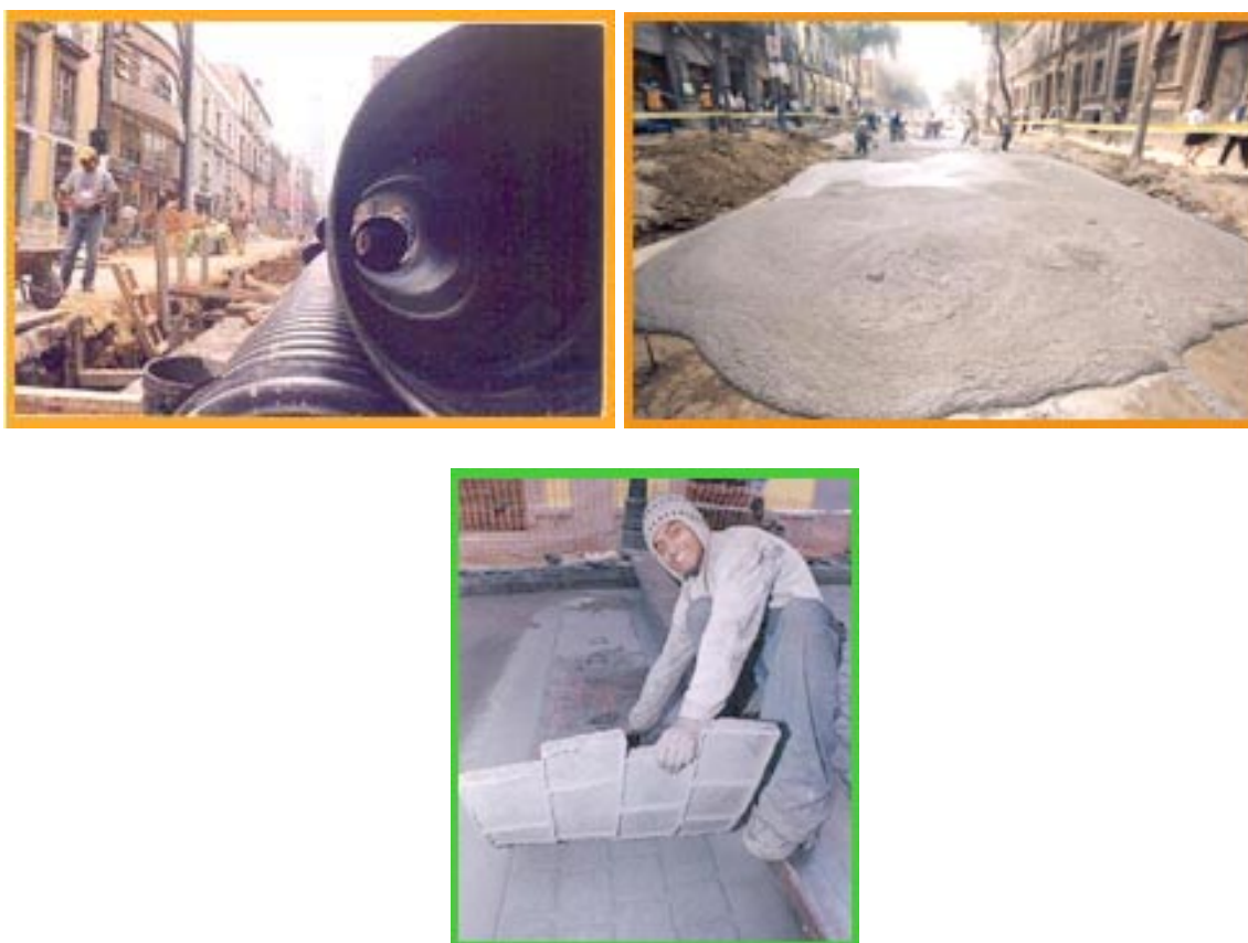
Figura. A2.23. Imágenes de la reintroducción de servicios de Drenaje por parte del G.D.F. Fotos: G.D.F.
