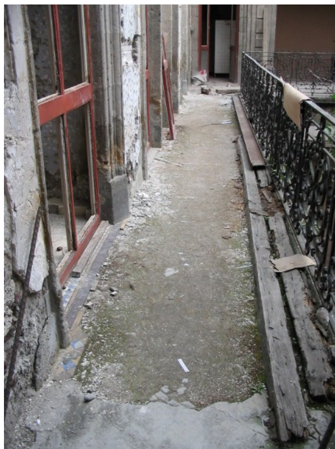
Figuras 3.20 y 3.21. Detalles de entrepiso característicos en los edificios coloniales en el centro histórico de la ciudad de México. Se aprecian las vigas de madera, el entramado de madera y el relleno de tierra, terminando con el piso a base de loseta de barro o loseta cerámica. Fuente propia.
