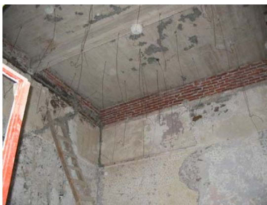
Sistemas constructivos mixtos.
