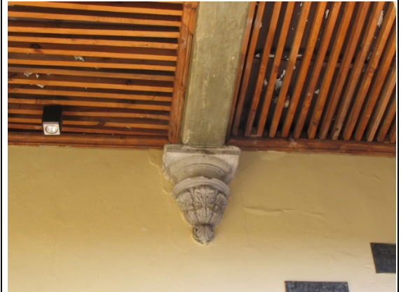
Detalles de intervenciones de restauración.
