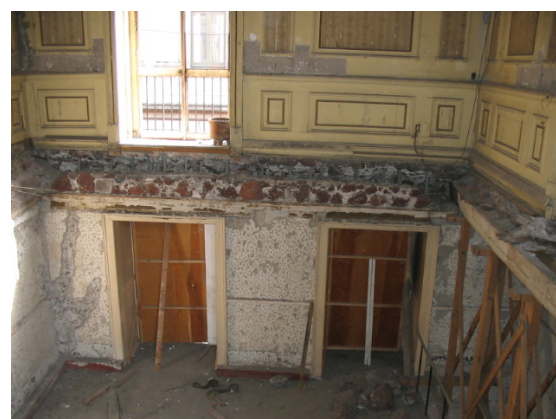
Zona sin entrepiso.
