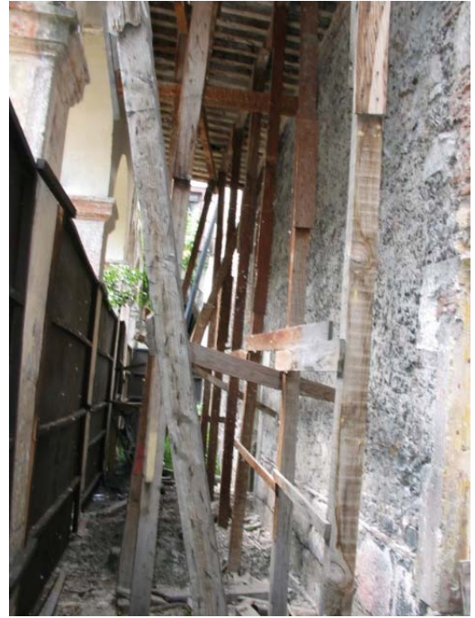
Apuntalamiento de la zona.
