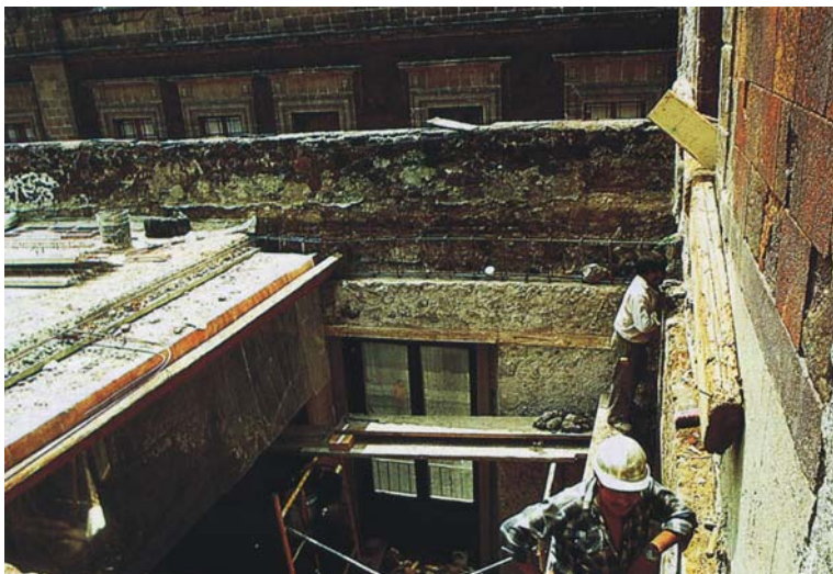
Figura A2.17. Intervención del edificio que alberga actualmente las instalaciones del PUEC de la UNAM. Fuente: PUEC.
