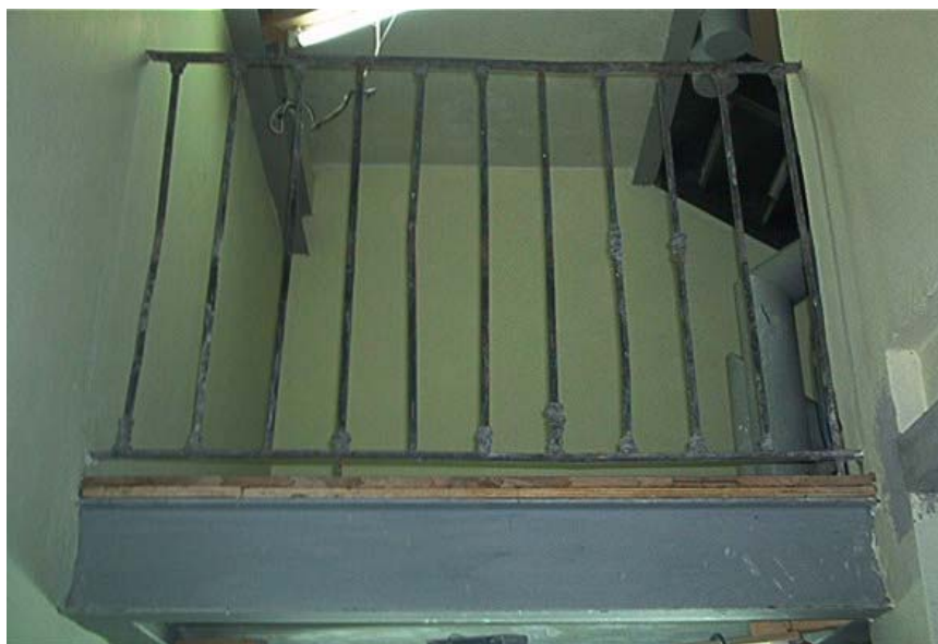
Figura A2.18 Viga de acero soportando un descanso de escalera, en el edificio del Palacio de Odontología. Fuente propia.
