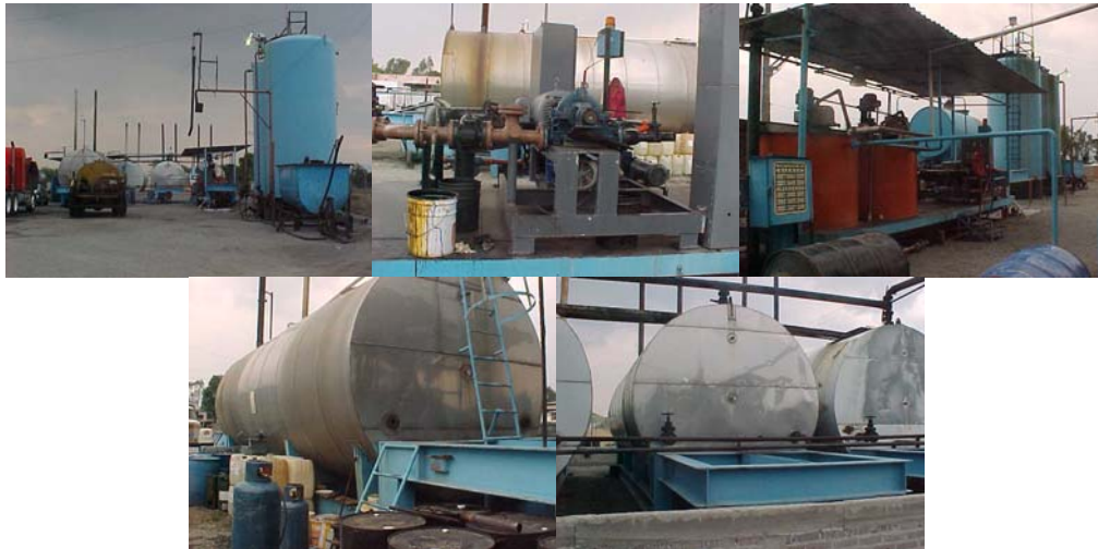
Figura 10 Planta productora de emulsiones y aditivos ubicada en carretera Texcoco Lechería km. 33+200 Tequisistlan Estado de México.
