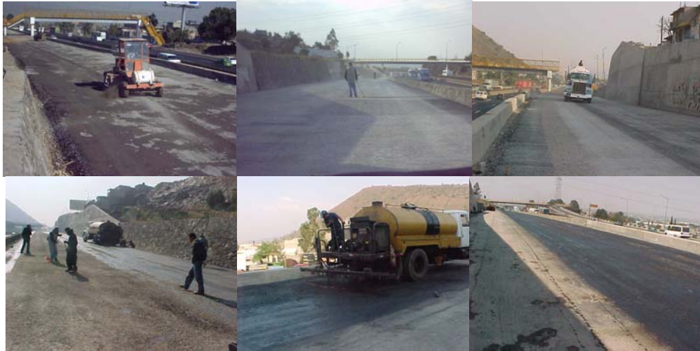
Figura 14 Aplicación del riego de liga de rompimiento rápido en tramo de obra de la autopista México – Puebla km. 19+420 al km. 19+720.
