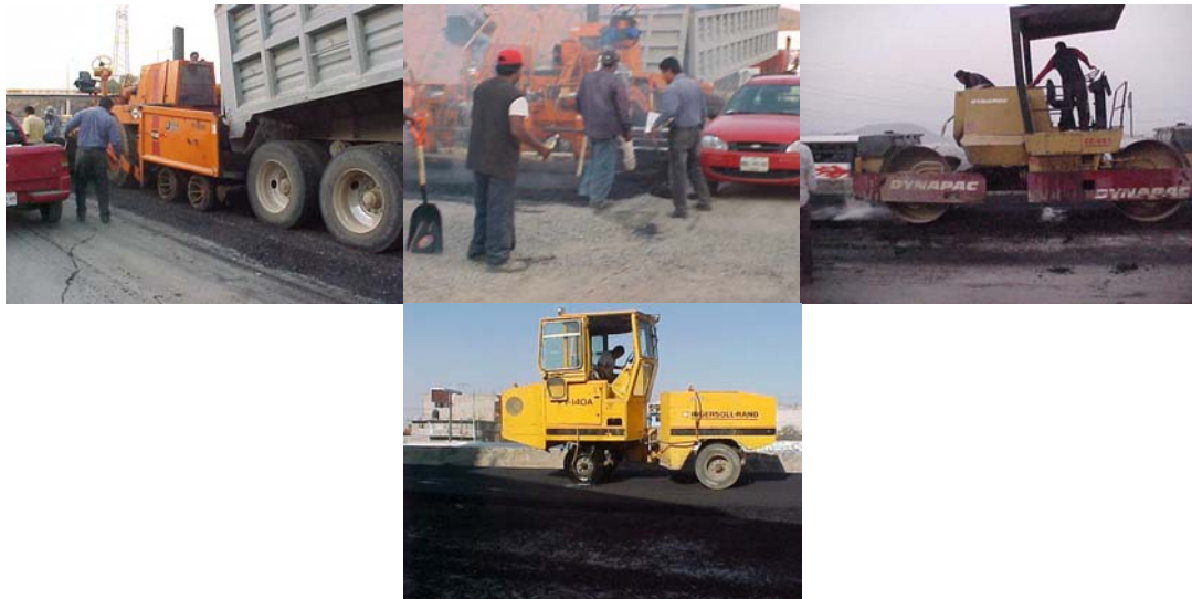
Figura 9 Colocación de mezcla asfáltica en caliente elaborada en planta con cemento asfáltico AC-20 modificada con polímero y agregados pétreos en un tramo de obra del km. 19+240 al 19+720 de la autopista México- Puebla.
