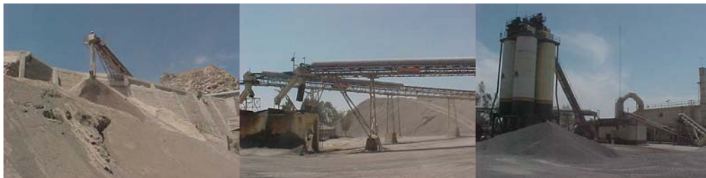
Figura 19 Planta de producción de agregados pétreos y mezcla asfáltica en caliente del grupo Tribasa planta Atlipac GCI. Ubicado en Carretera Federal – México Puebla Km. 27.5 Prolongación Pirul s/n Col. Valle Verde C. P. 56570 Iztapaluca Estado de México.
