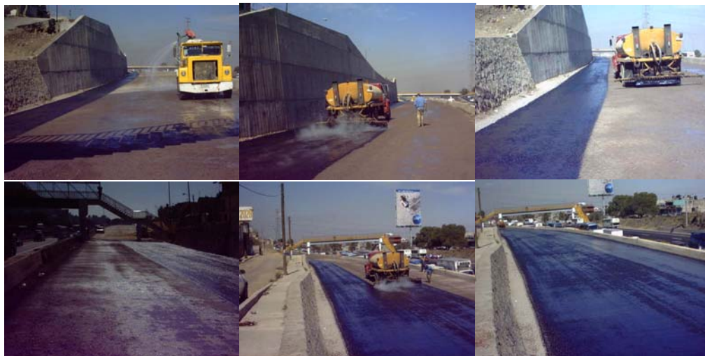
Figura 13 Aplicación del riego de impregnación de rompimiento lento en tramo de obra de la autopista México – Puebla km. 19+420 al km. 19+720.
