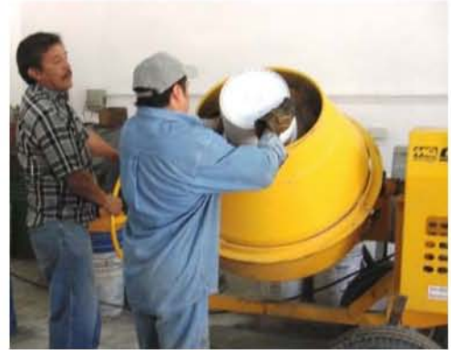
Fig. III.2 Colocación de componentes de la mezcla
