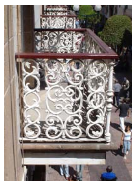
Balcón fabricado en fierro fundido. Actualmente todos los balcones se conservan en buen estado.
