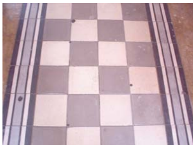
Mosaicos de pasta de cemento que aún se conservan en los departamentos 1 y 3.
