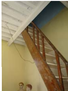
Escalera original de madera del torreón oriente de la fachada principal.
