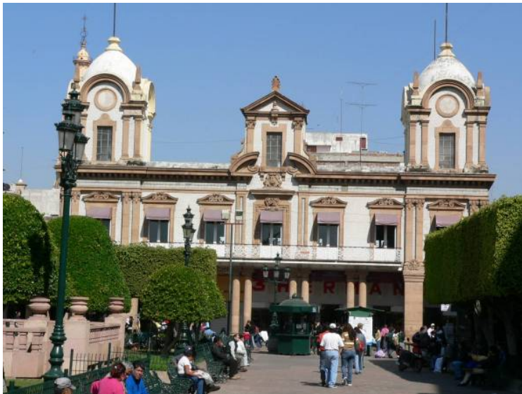
Fachada norte como luce actualmente.
