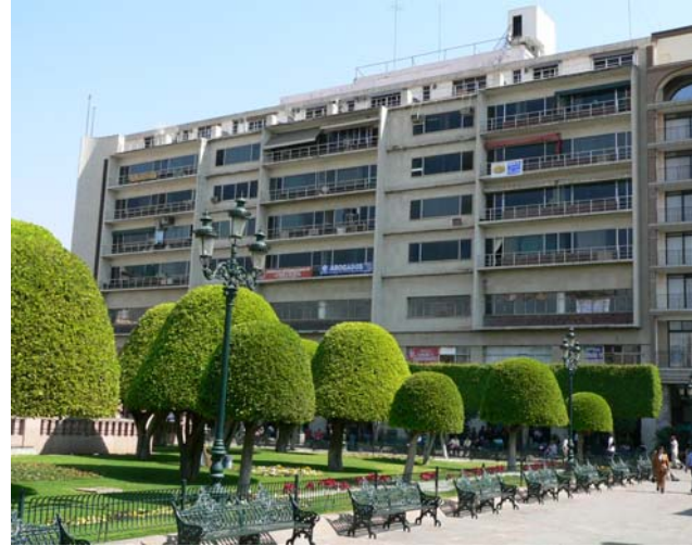
Edificio Pons construido en el Portal Bravo una vez demolidos los edificios anteriores. Fotografía actual.
