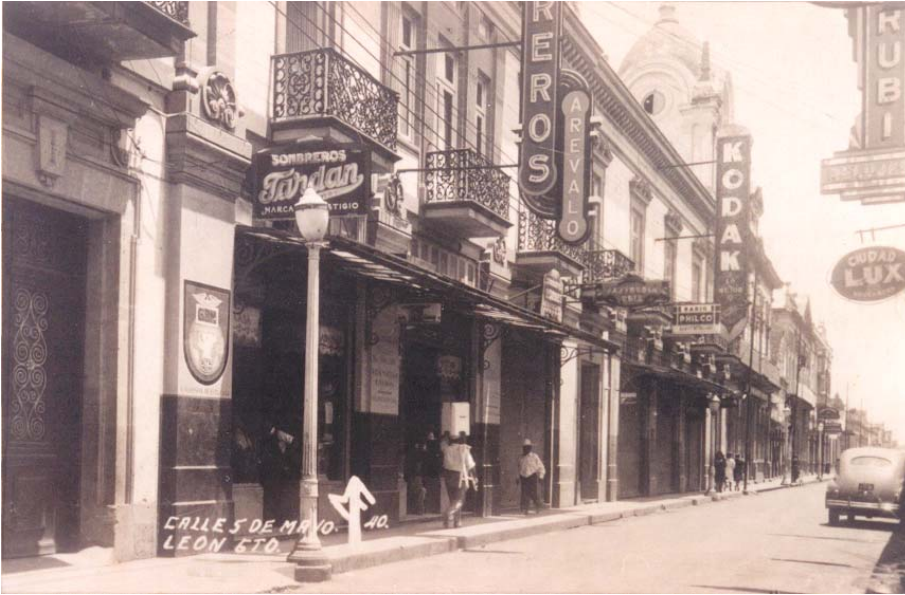
Almacenes del Edificio Madrazo en planta baja en las primeras décadas del siglo XX.
