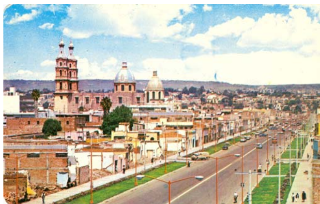
Apertura del Boulevard López Mateos, se pueden observar fincas que fueron destruidas para poder llevar a cabo la obra.
