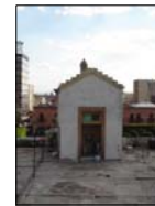
tuberías en azotea
